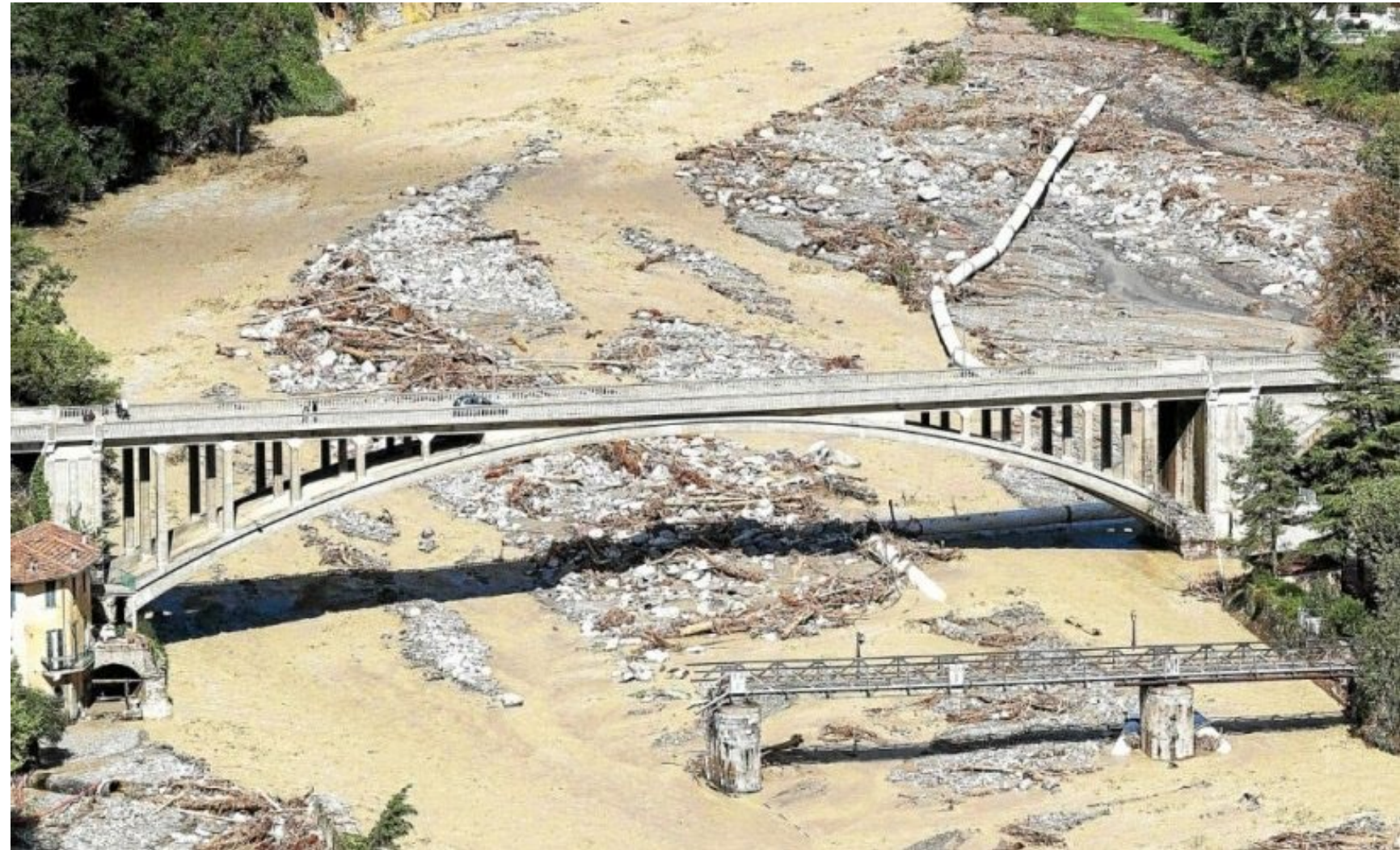
Pont à arche unique et pont à travées multiples à Roquebillière (Photo : La voix du Nord)
