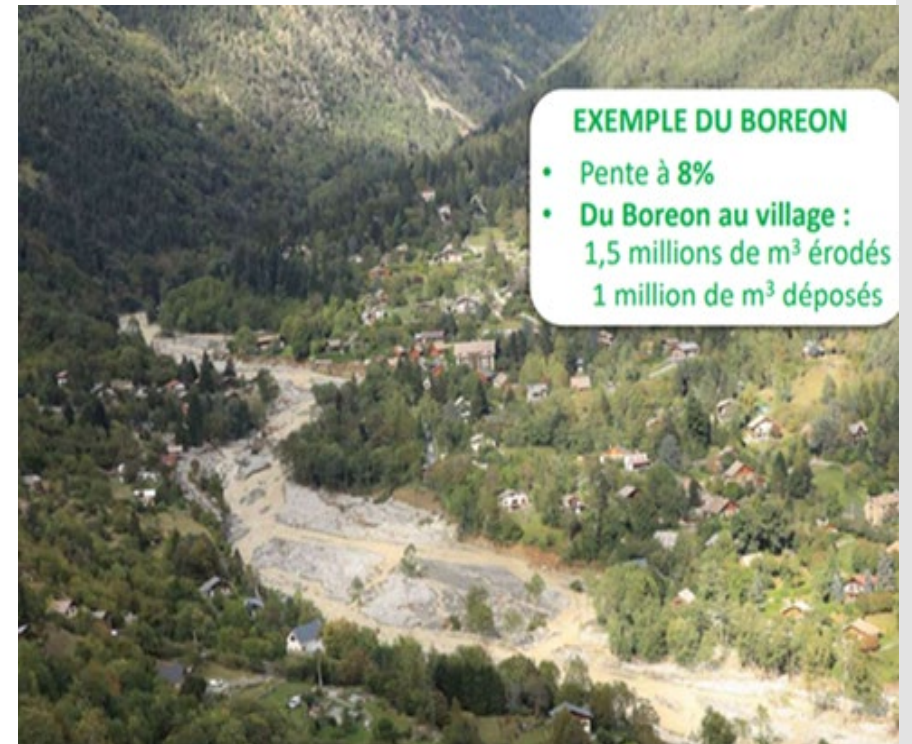
La charriage de sédiments dans le torrent du Boréon en amont du village de St Martin Vésubie (Source : Service RTM, 2021)
