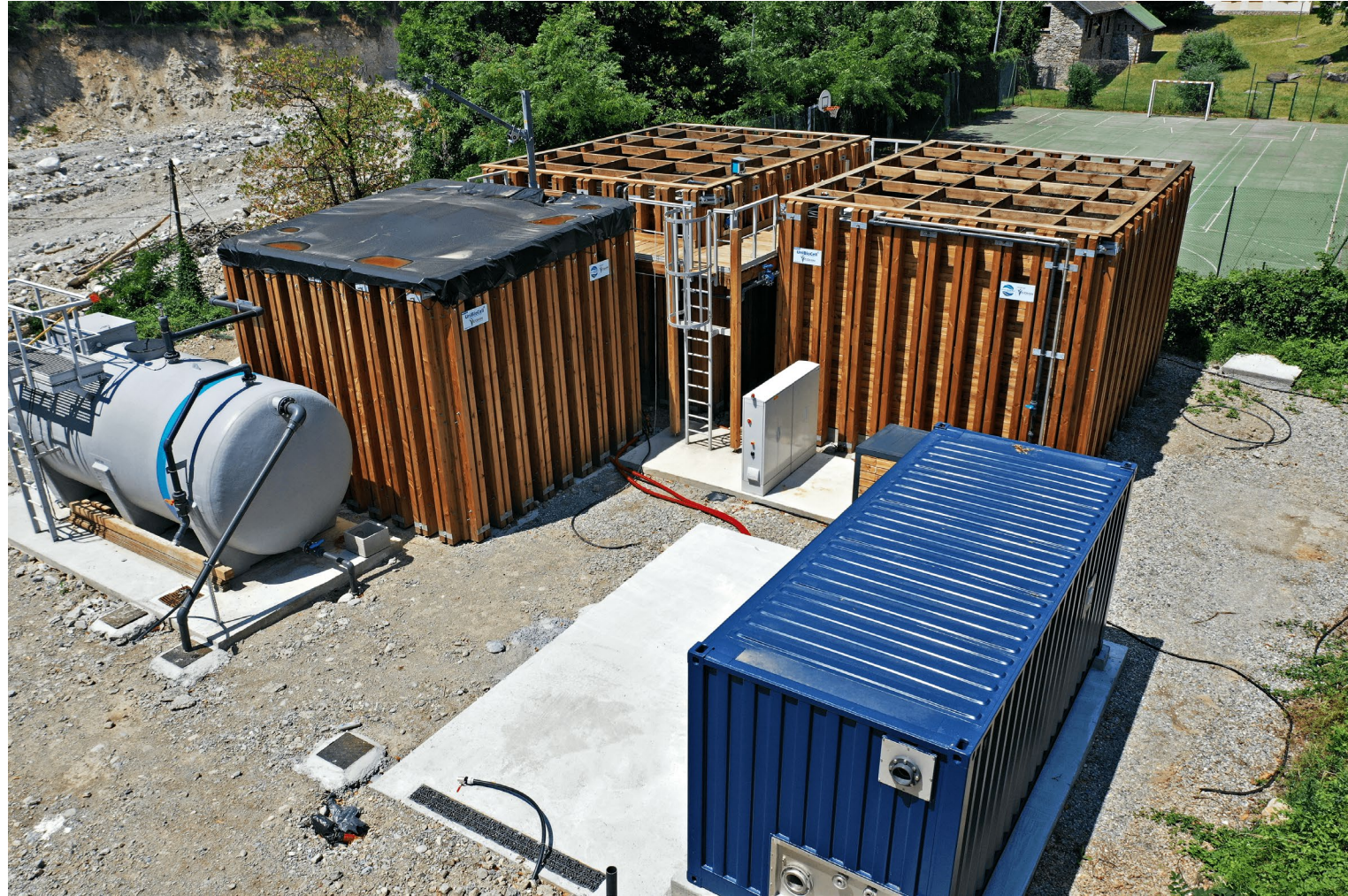
La station d'épuration reconstruite à St Martin Vésubie suite à la Tempête Alex (photo : Cohin Environnement)
