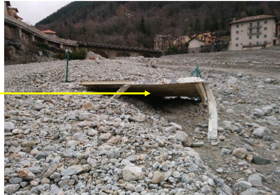
Le toit de la tribune du stade de football de St Martin Vesubie (Photo : JC TEOBALDI)
