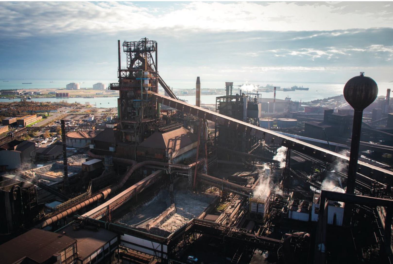
Vue sur un haut fourneau.
