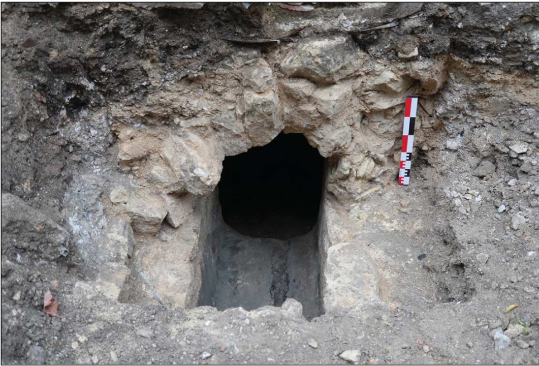
Fig. 2 - Paris (6 e arr.) - 14 rue Bonaparte (École nationale des Beaux-Arts) : vue de la canalisation sud et du puisard. Cliché J.-F. Goret/DHAAP
