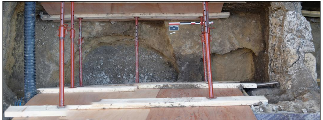
Fig. 24 – Paris (4 e arr.) – 47 rue Vieille du Temple – 10 rue des Guillemites : tranchée de diagnostic, secteur 2 (Cliché : P. Saussereau/DHAAP).
