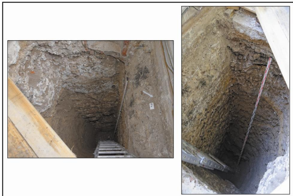
Fig. 16 – Paris (4 e arr.) – 47 rue Vieille du Temple – 10 rue des Guillemites : sondage P6, vues du sondage (Clichés P. Saussereau/DHAAP).
