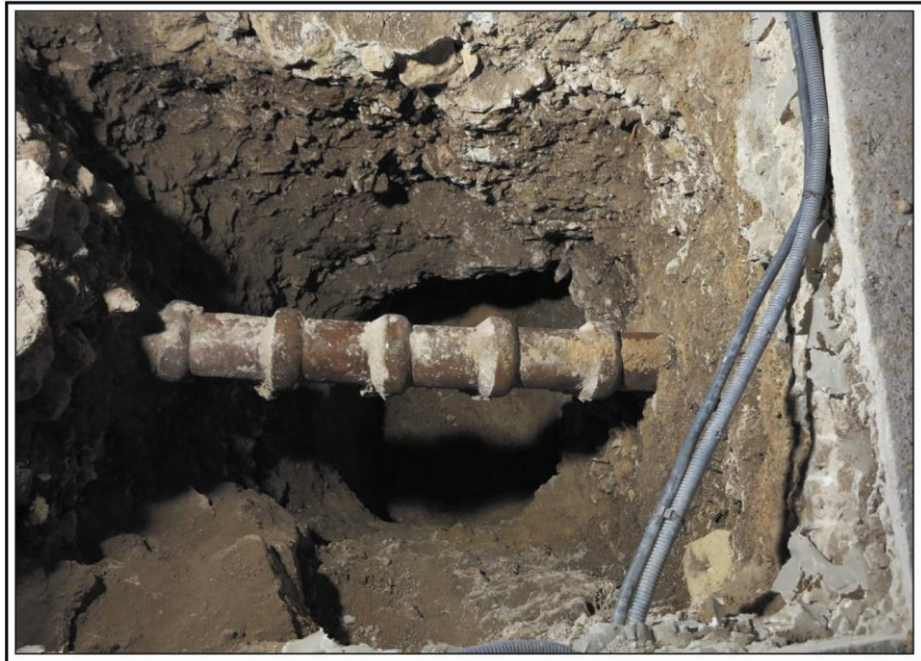
Fig. 20 – Paris (4 e arr.) – 47 rue Vieille du Temple – 10 rue des Guillemites : sondage P12, vue du sondage (Cliché J.-F. Goret/DHAAP).
