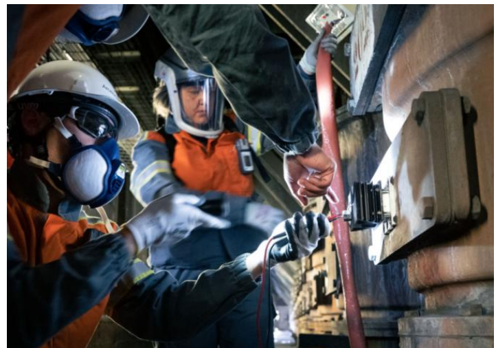
Fig. 2. Mise en place de l'ensemble dissipateur / thermogénérateur sur la BAF
