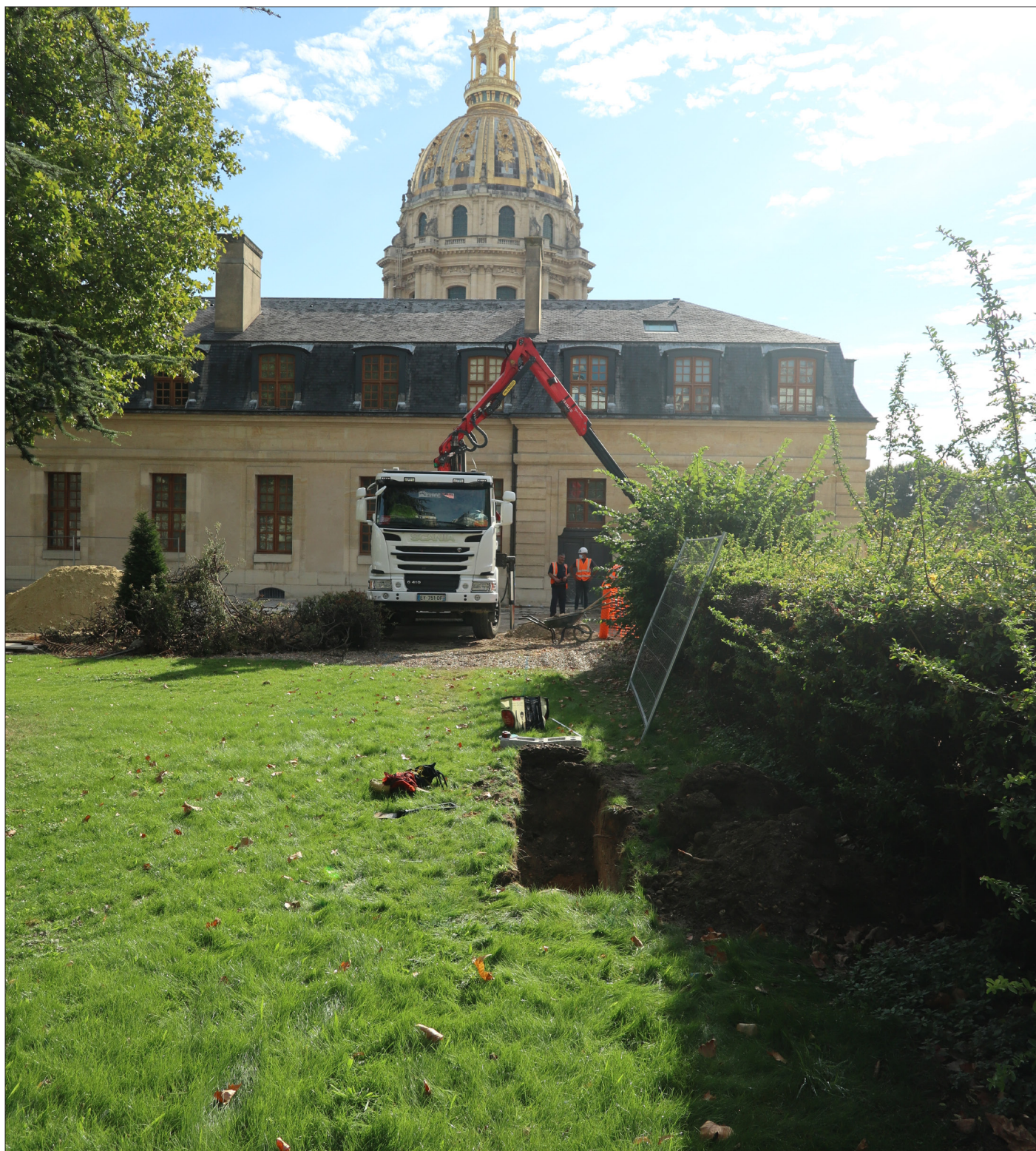
Figure 1 : tranchée de raccordement interrompue après la découverte des ossements humains
