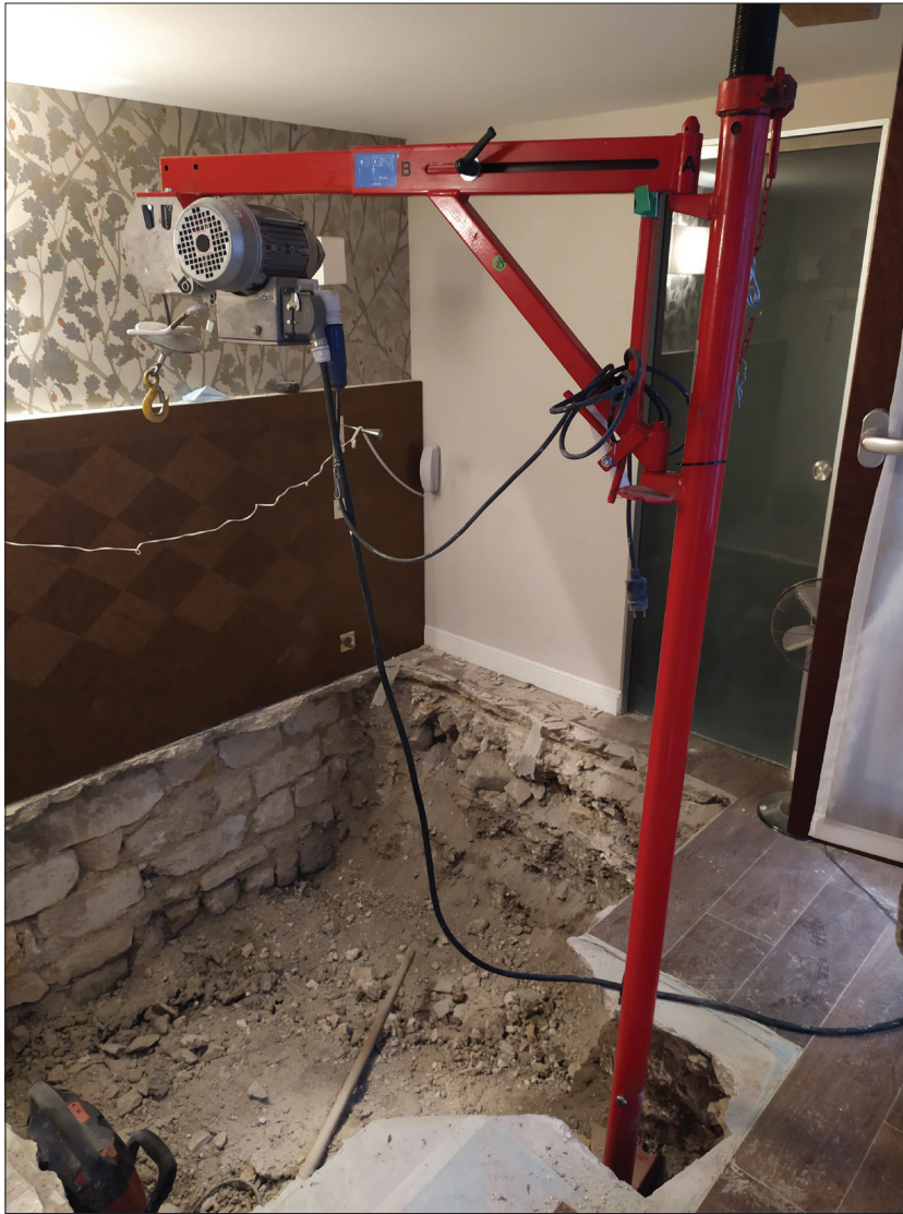
Fig. 5. Vue générale du sondage prise de la paroi « nord ». Cliché : David Couturier, DHAAP
