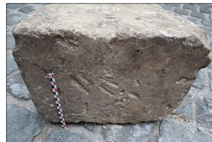
Fig. 17. Bloc de moyen appareil avec traces d'outil. Cliché : David Couturier, DHAAAP.
