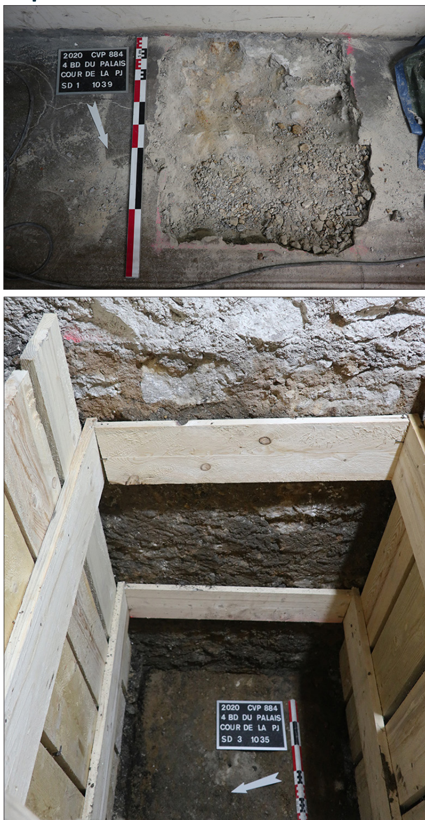
Fig. 7. Les sondages de reconnaissance de fondation 1 et 3. Cliché : David Couturier, DHAAP.
