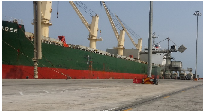
Photo 6 : Déchargement du ciment au port de Tema
