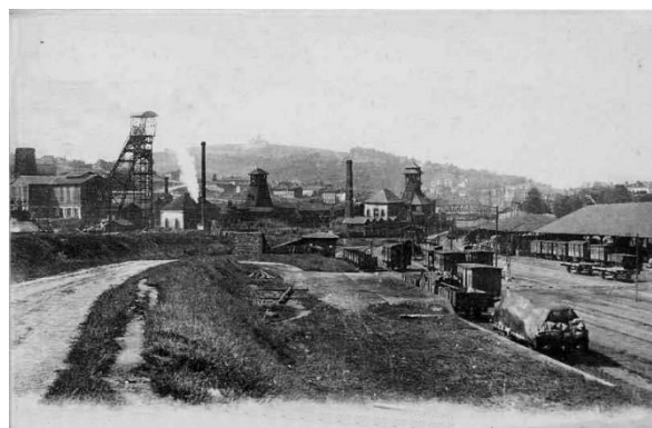
Fig. 10. Saint-Étienne (Loire). Le puits Châtelus.
