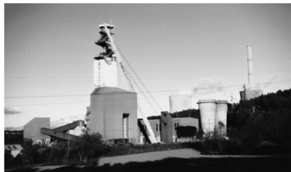
Fig. 12: Le puits Z à Gardanne (Bouches-du-Rhône) 1998. Photo P. C. Guiollard
