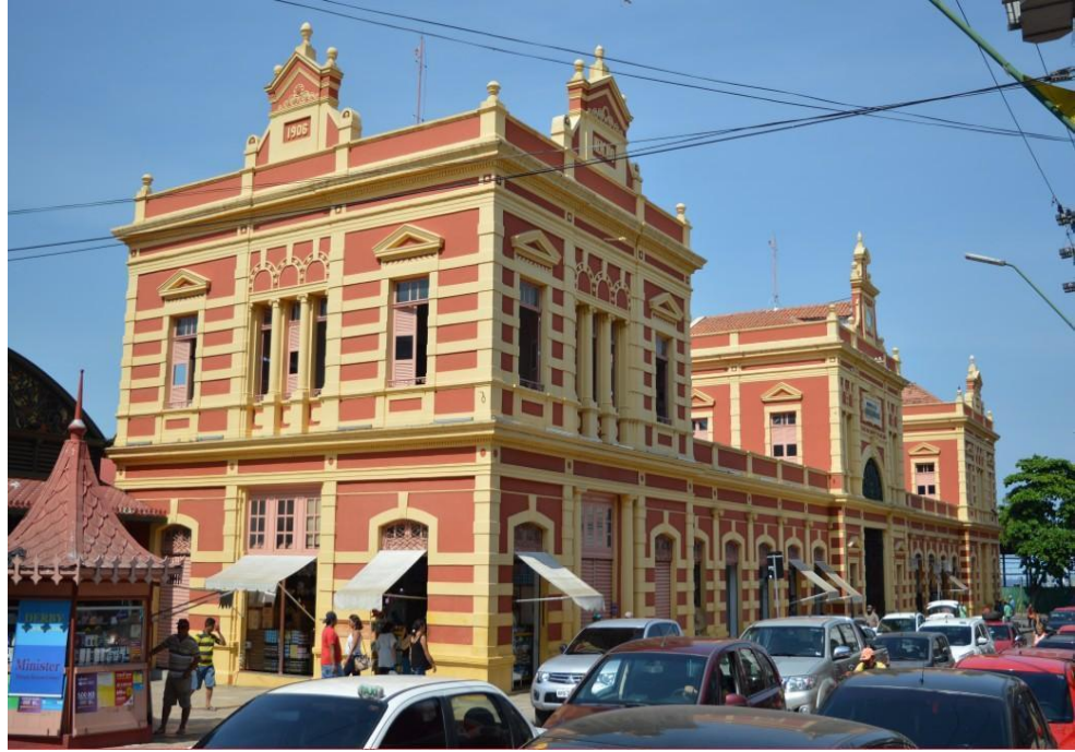
Segunda fachada do Adolpho Lisboa (Rua dos Barés), a outra é para frente do rio Negro
