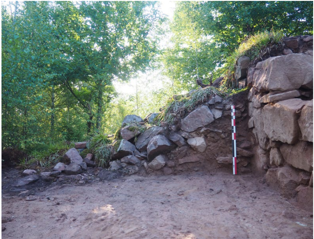
Fig. 53. Vue en coupe du cône d'éboulis reposant contre la face externe nord du mur MR1001 depuis l'ouest. Cliché : F. Minot
