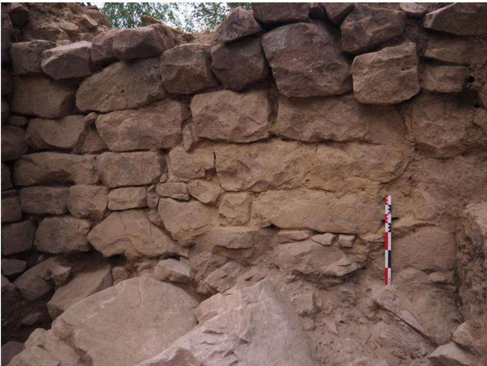
Fig. 52. Détail de la fondation et des joints indurés du parement interne de la section nord du mur MR1001. Cliché : F. Minot
