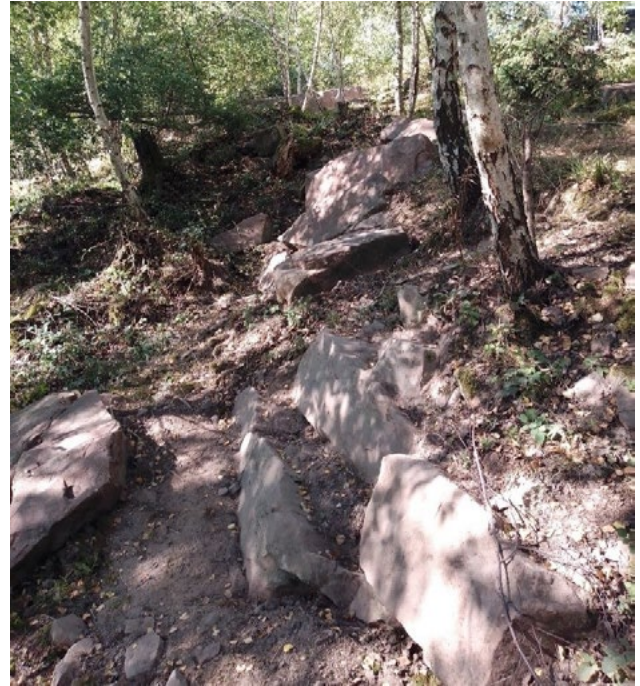
Fig. 27. Vue générale du secteur dit « carrière ». Cliché : P. Elsass
