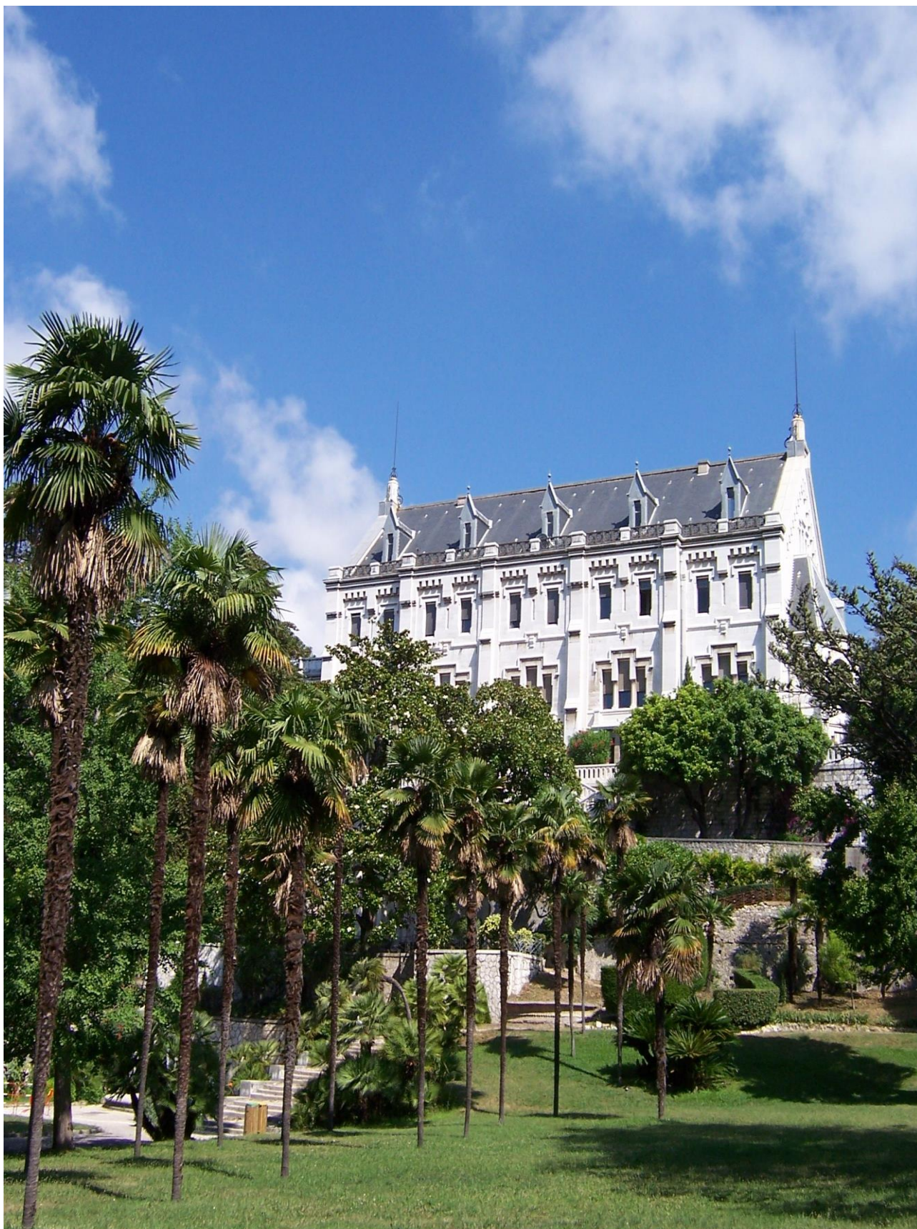
Château de Valrose : façade sud sur parc
