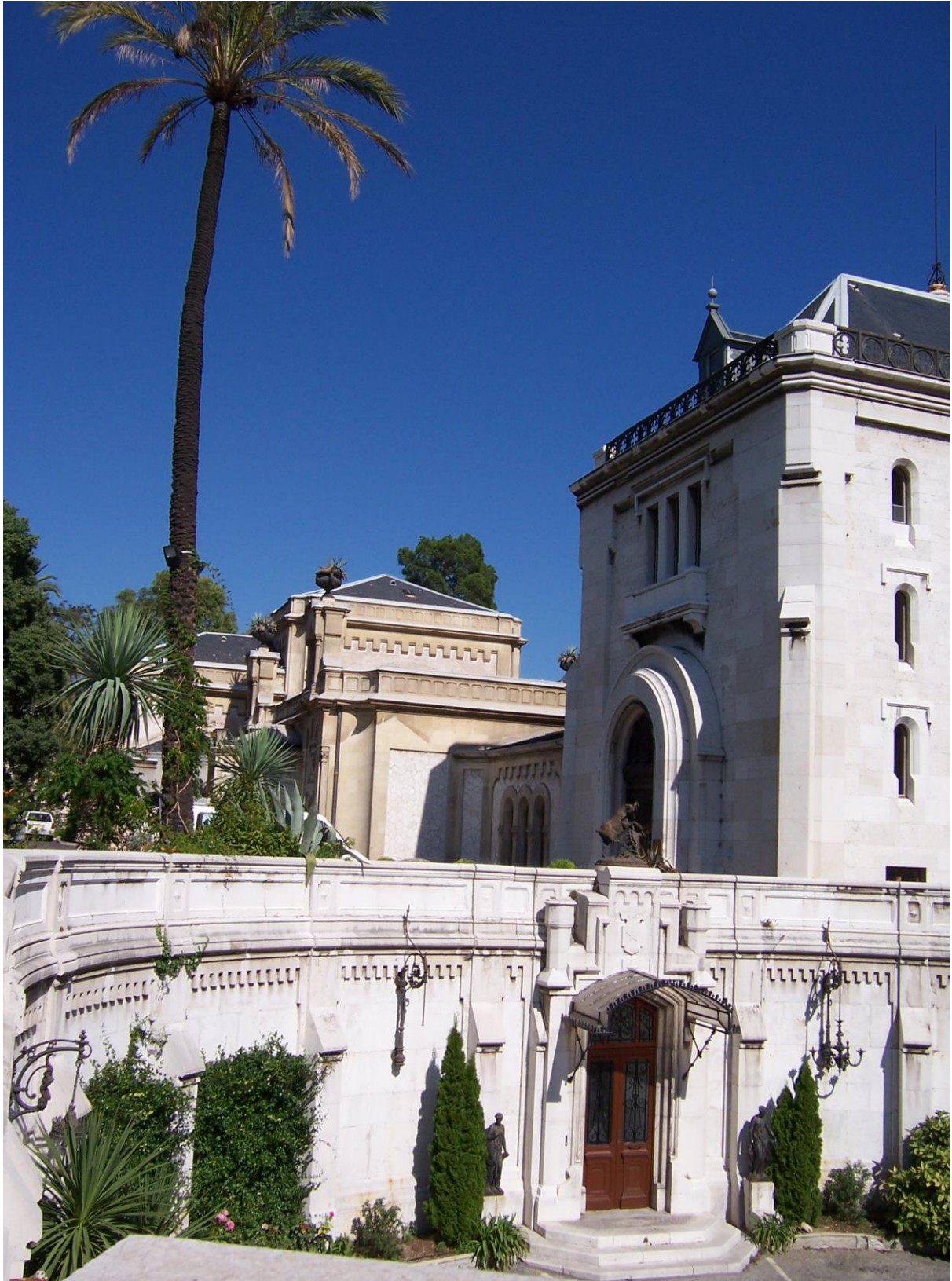
Entrée d'honneur du Théâtre (parvis supérieur) surmontant l'entrée secondaire (parvis inférieur)
