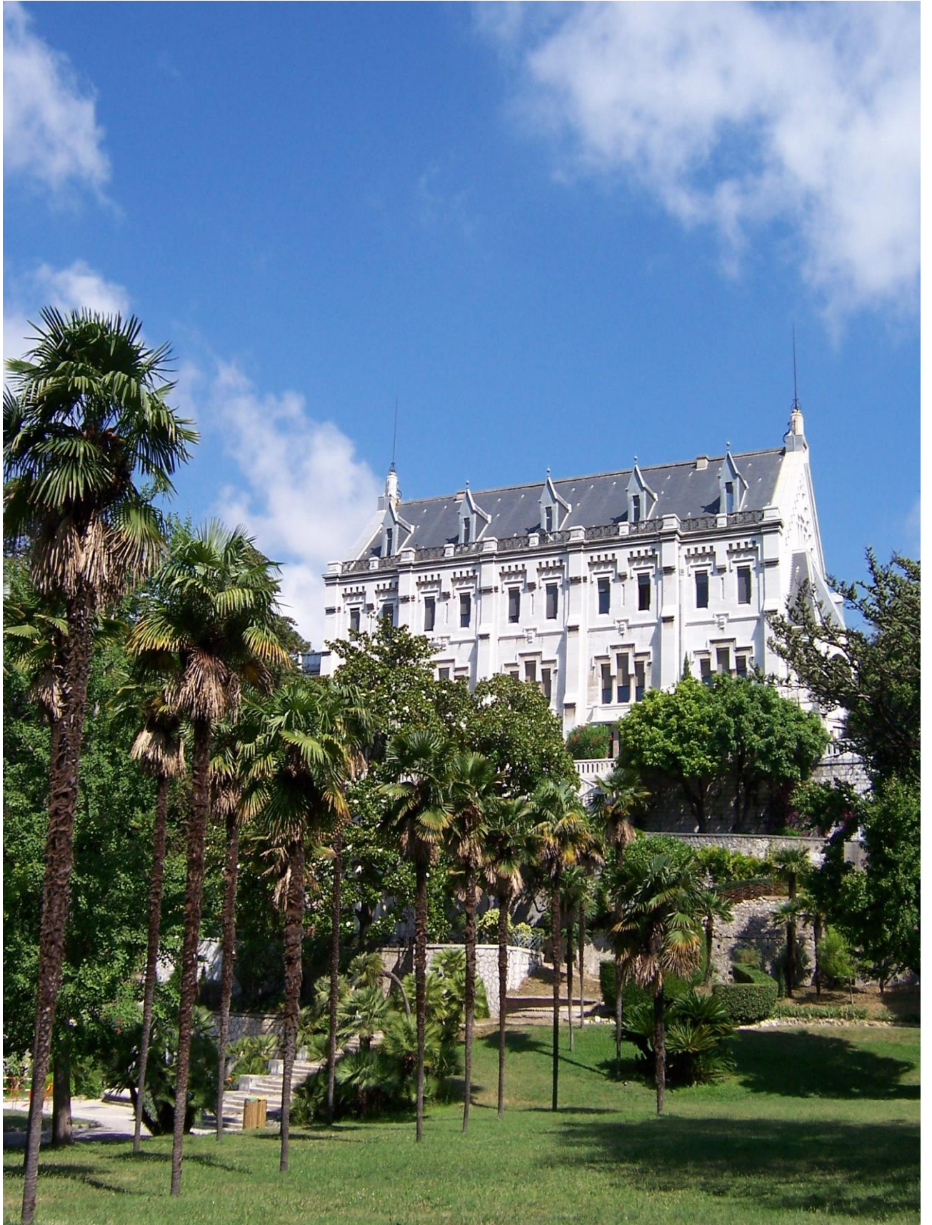
Château de Valrose : façade sud sur parc
