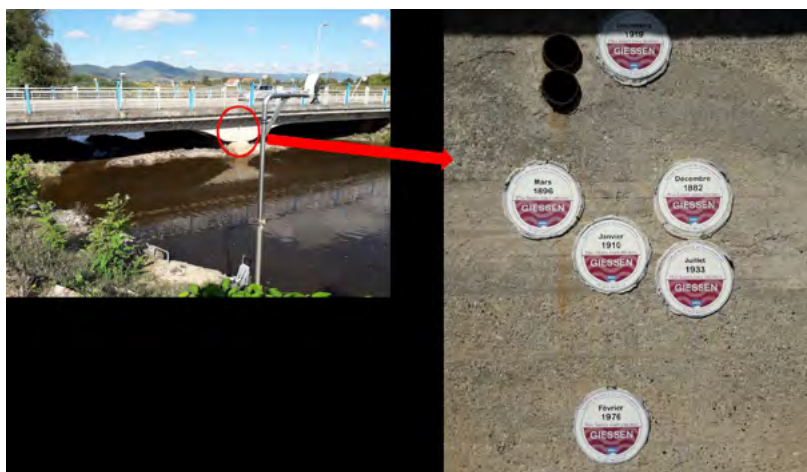
Repères de crue posés par le SDEA Alsace-Moselle sur le pont du Giessen, à Sélestat. © Jean Gerling, SDEA, 2018
