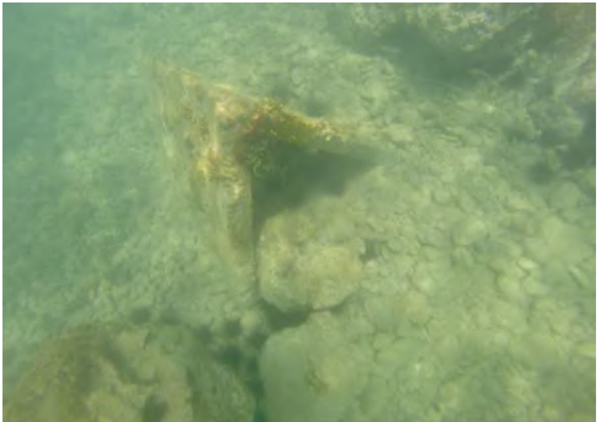
Figure 21 : Photos du haut, colonisation des pyramides en béton, premiers récifs artificiels volontaires haïtiens. Photo du bas, une pyramide couchée, du fait des effets des houles et vagues (photos : Stryhanin).
