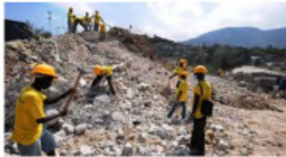
Débris inertes de construction valorisés (déchets disponibles) – NPR Haïti
