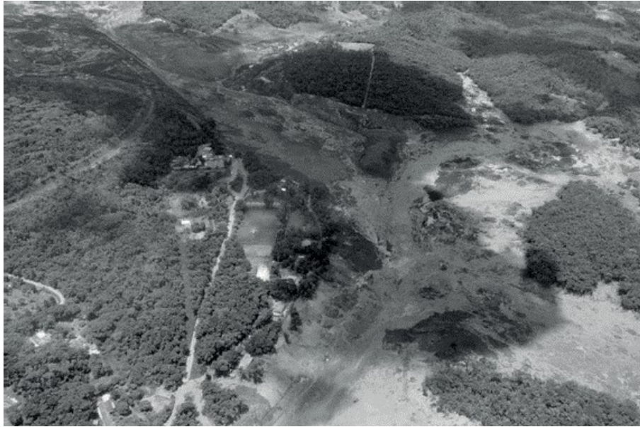
Figure 1 : Le barrage de Córrego Feijão, à Brumadinho, au Brésil, a cédé vendredi [crédit photo : Corpo de Bombeiros/Divulgação]
