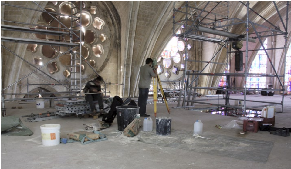
Fig. 1 – Relevés topographiques et manuels sur l'échafaudage (photographie J. Viret).
