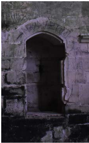
FIG. 30 : Niche crédençe dans le mur nord de la chapelle (©Cabinet Bortolussi).
