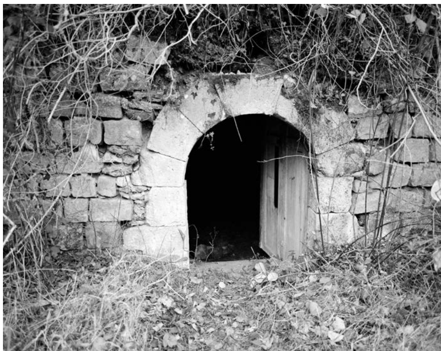
FIG. 66 : Vue sur l'entrée de la cave en 1985 (©J.-P. Vialles dans notice Mérimée IA00051989)
