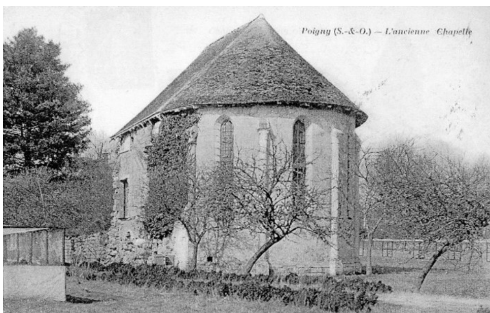
FIG. 90 : Vue de la chapelle depuis l'est. A droite et à gauche, des parquets de faisanderies (©Collection privée)
