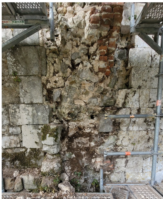
Fig. 100 : Vue sur le départ de mur de brique, premier niveau, face sud de la chapelle (Etienne Courné).
