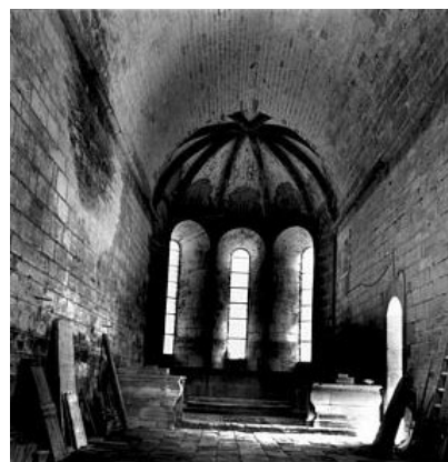
FIG. 29 : Voûte sur croisé d'ogives, Prieuré du Bois-D'allonne (©Ministère de la Culture).
