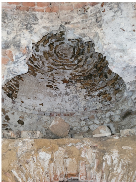
FIG. 101 : Vue sur la voûte de l'abside circulaire sud-ouest du nymphée (Etienne Courné).
