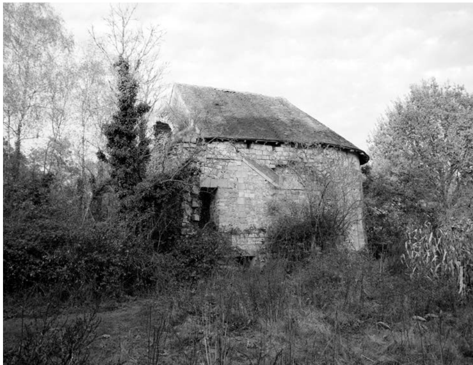
FIG. 72 : Vue du sud-ouest de la face sud de la chapelle. Le départ de voûte brique de l'escalier est visible en façade avec une pente ascendante d'est en ouest (©J.-P. Vialles dans notice Mérimée IA00051989).
