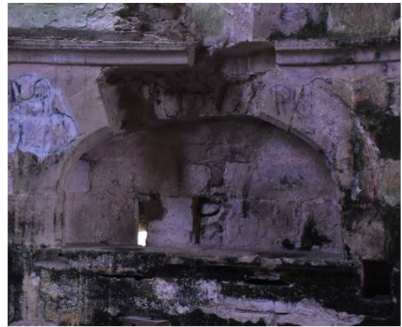
FIG. 31 : Piscine/Lavabo liturgique dans le mur sud de la chapelle (©Cabinet Bortolussi).
