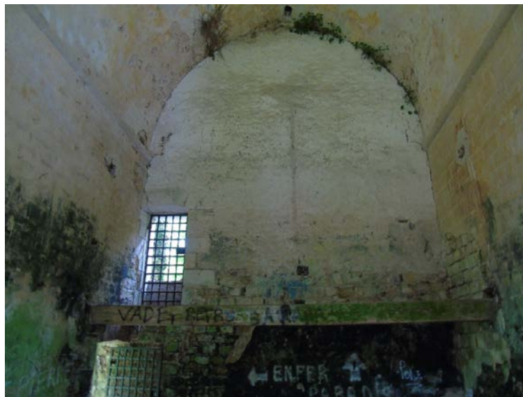
FIG. 59 : Mur de fermeture de la chapelle à l'ouest, vue de l'intérieur (Etienne Courné).
