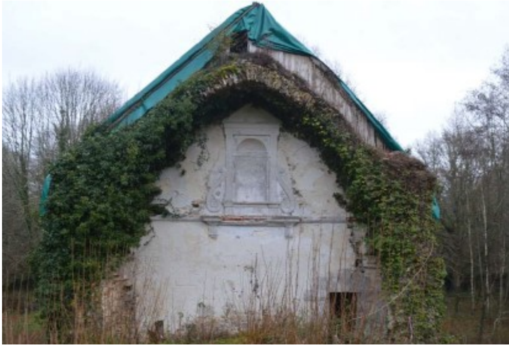
FIG. 65 : Vue sur la niche du mur de séparation, façade ouest de la chapelle en 2020 (Etienne Courné)
