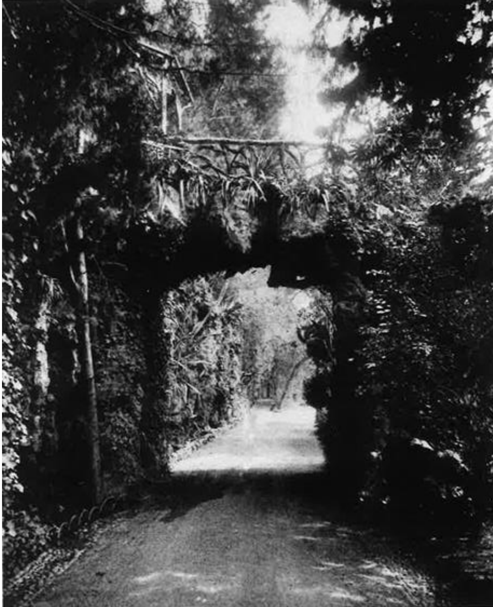
Passerelle avec rambarde à l'imitation de ramures en bois, détail qui se retrouve fréquemment dans la parc. Cette passerelle relie initialement le parc à la partie verger et potager de l'avenue Joseph Vallot : trait d'union entre un jardin d'Eden recomposé et la ville environnante.
