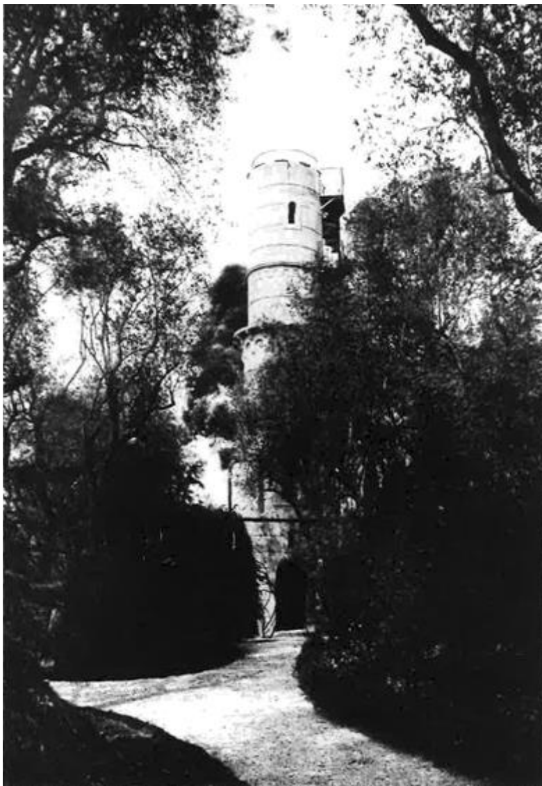
Une haute tour d'inspiration vaguement moyenâgeuse sert de château d'eau, à la lisière du parc Liserb et non loin de la Villa Montebello.
