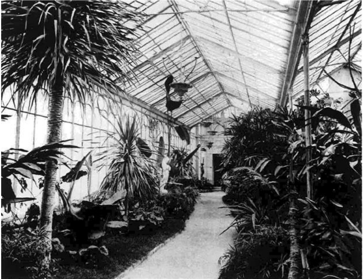
Jardin d'hiver, véritable serre d'intérieur, constituant un passage protégé entre la terrasse belvédère et le vestibule desservant à la fois l'escalier d'honneur du théâtre et la salle à manger.
