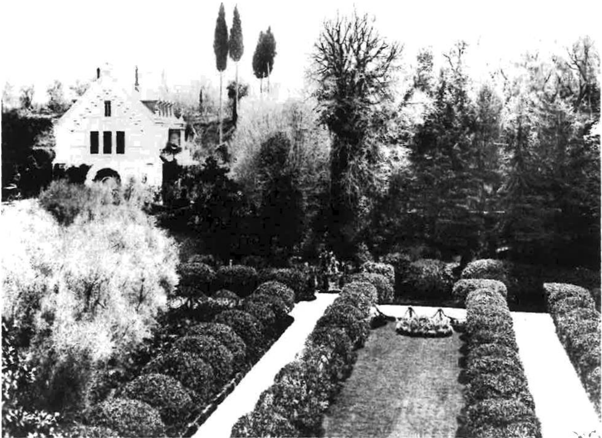
Au « Grand Château » fait partiellement face le « Petit Château », édifié par l'architecte parisien Bérenger pour l'hébergement des invités. Sa façade latérale à pignon apparaît à gauche, en arrière de la grande allée.
