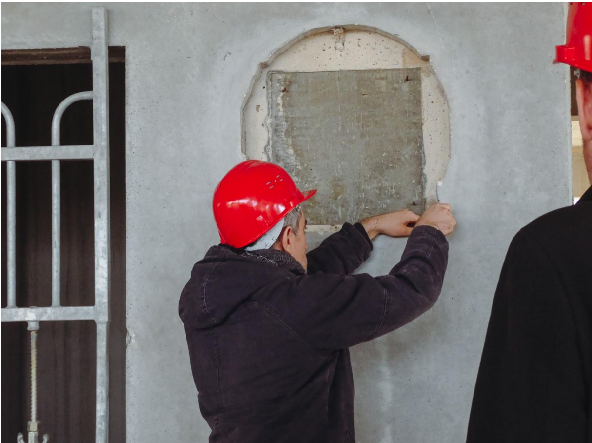
Figure 2 – L'artiste travaillant avec les architectes sur l'empreinte béton de son œuvre à Saint-Ouen (Ruestchmann, février 2022)
