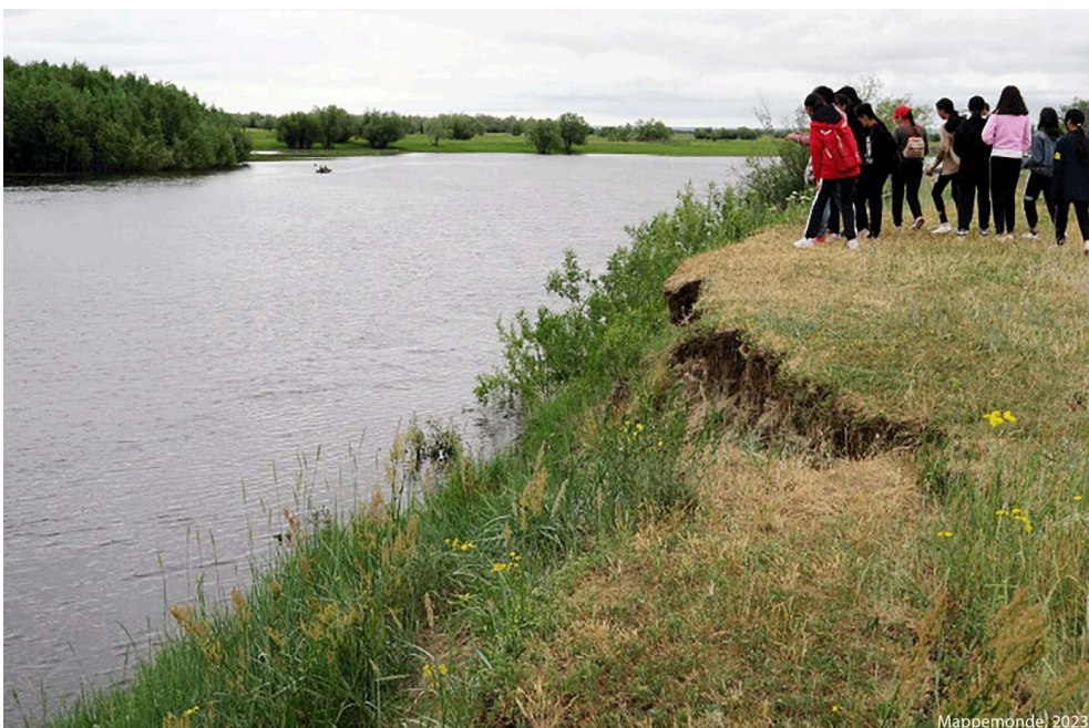
Photo 3. Érosion des berges
