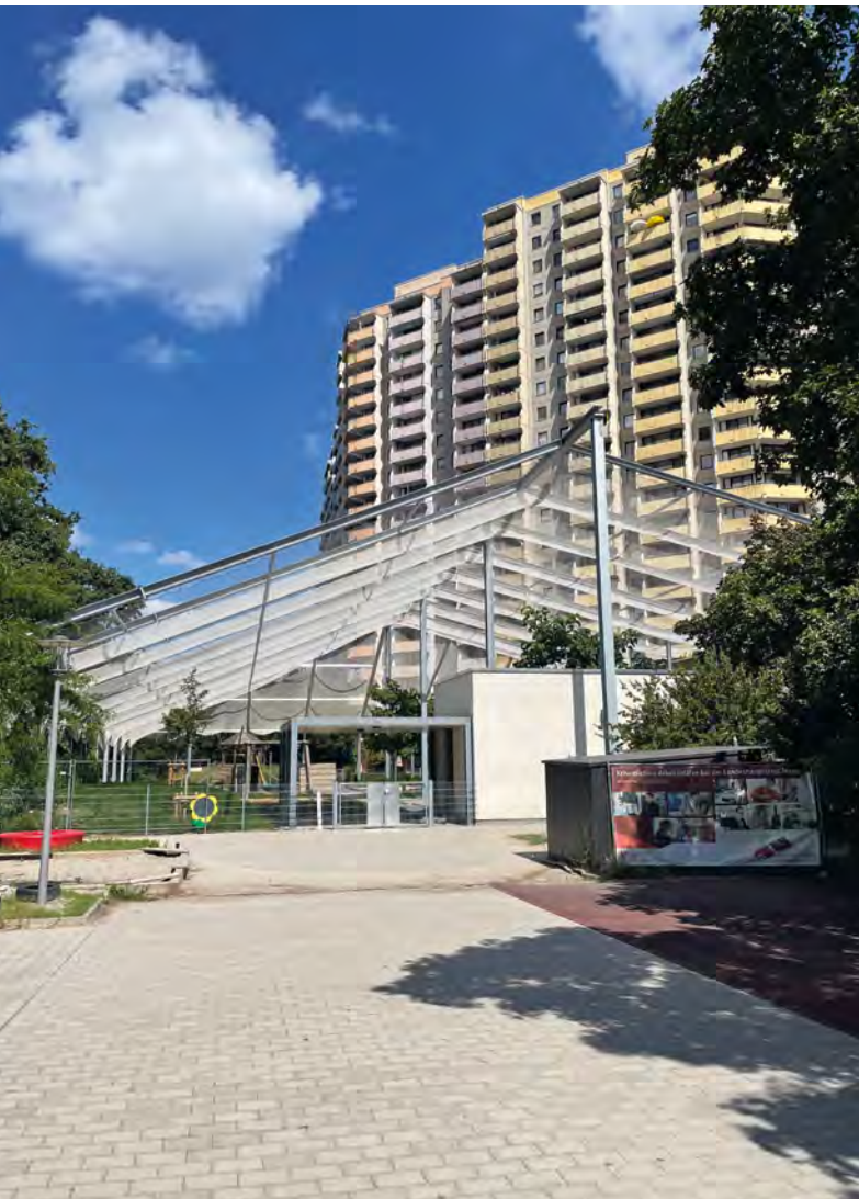
Abbildung 32: Netz über dem Kindergarten (Foto: Rainer Kazig)
