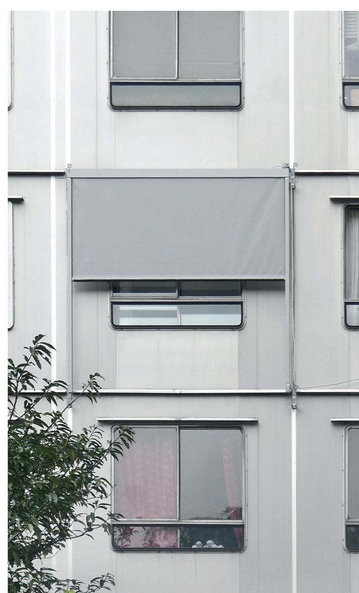
Prototype pour la réhabilitation des façades légères installés sur l'immeuble Les Cèdres
