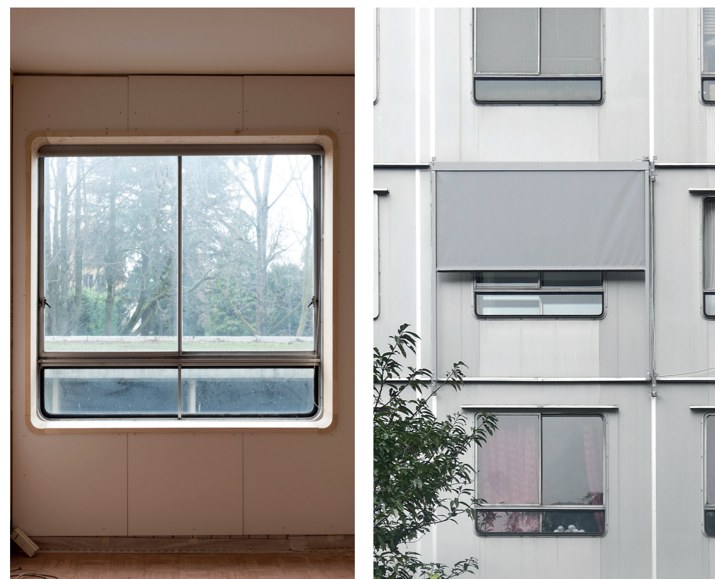
Prototype pour la réhabilitation des façades légères installés sur l'immeuble Les Cèdres
