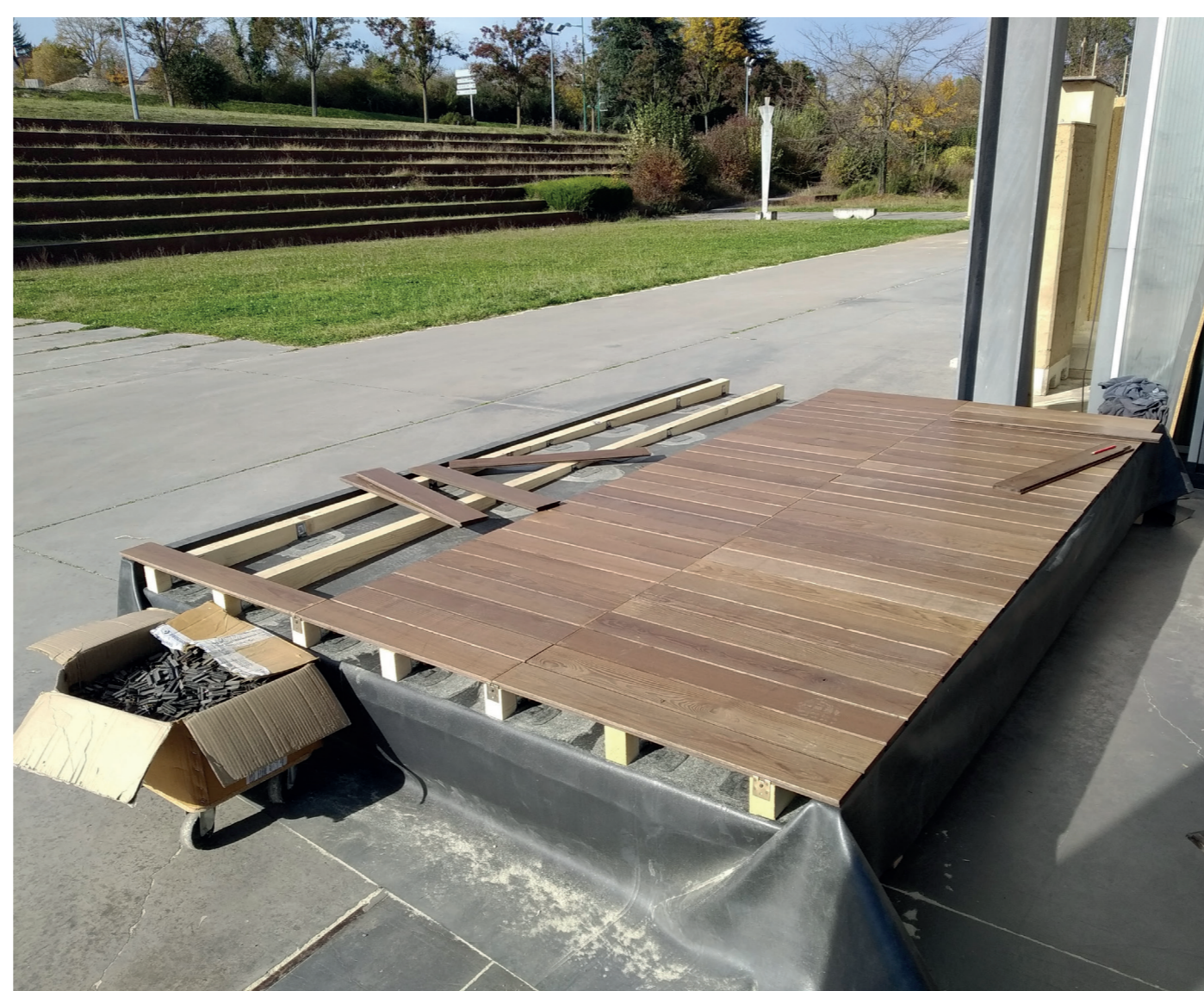
Module de plancher de la serre agricole hors-sol
