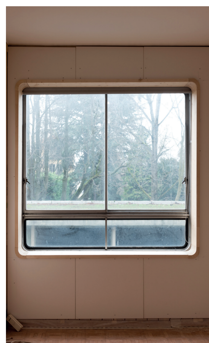
Prototype pour la réhabilitation des façades légères installés sur l'immeuble Les Cèdres
