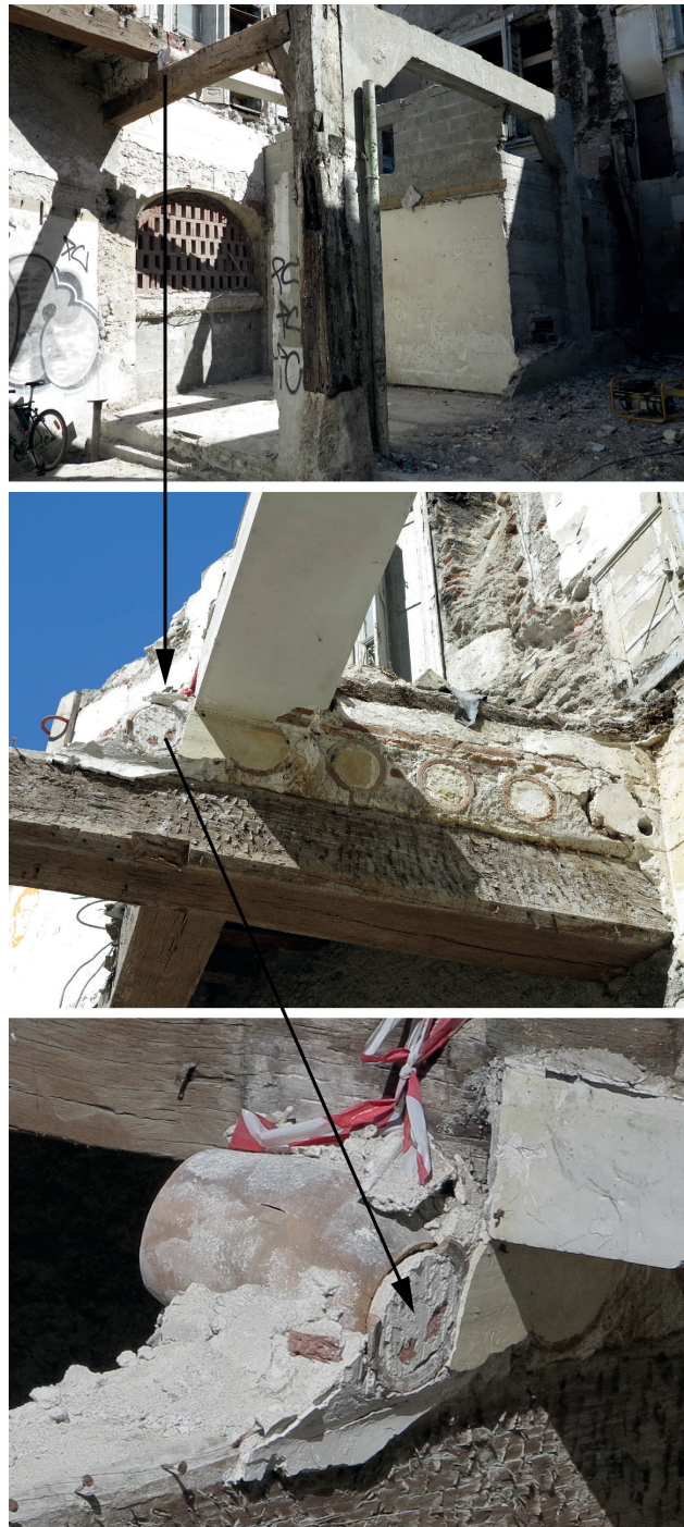
Fig. 35 : Orléans, hôtel de Fougeu d'Escures n° 2 rue d'Escures : pots d'allègement dans le plafond entre le rez-de-chaussée et l'étage du corps de bâtiment nord de la cour (cliché : Clément ALIX, Pôle d'Archéologie Ville d'Orléans).
