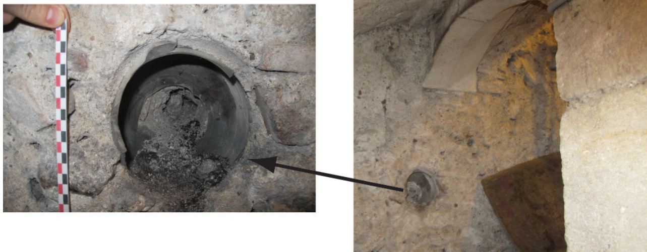
Fig. 23 : Orléans, maison n° 20 Cloître Saint-Aignan : vue de la céramique encastrée dans le mur est de la cave près de la porte de la cage d'escalier (cliché : Clément ALIX, Pôle d'Archéologie Ville d'Orléans).
