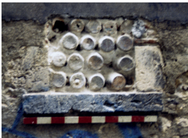
Fig. 6 : Orléans, rue de la Folie : pots à mélasse remployés pour obturer une ouverture dans l'îlot Nazareth (cliché : Pascale DUPONT, Pôle d'Archéologie Ville d'Orléans).
