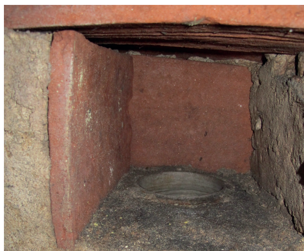
Fig. 26 : Orléans, maison n° 83 rue Malakoff : vue de la céramique engagée dans l'appui d'une niche à l'intérieur de la cellule latérale ouest de l'escalier de la cave-carrière (cliché : Clément ALIX, Pôle d'Archéologie Ville d'Orléans).
