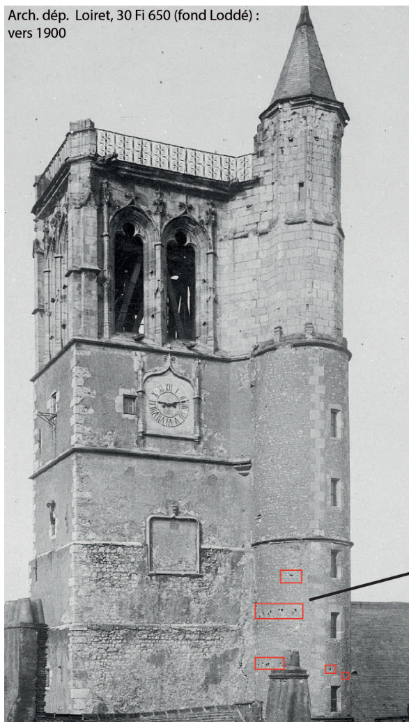
Fig. 13 : Orléans : photographies du début du XX e s. du beffroi de l'hôtel de ville, avec pots en céramique insérés sur la tourelle d'escalier vers 1448 (Arch. dép. Loiret, 30 Fi 650 ; Médiathèque de l'Architecture et du Patrimoine, Charenton-le-Pont, 0081/045/0048).
