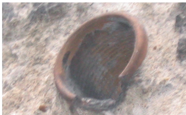
Fig. 12 : Orléans, maison 34 rue de la Charpenterie : un des quatre pots à oiseau insérés au sommet du mur de clôture ouest de la cour (cliché : Clément ALIX).
