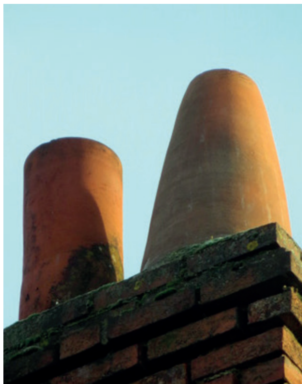
Fig. 7 : Orléans, maison rue Stanislas-Julien : exemple de mitron de cheminée (à droite) façonné à partir d'une forme à sucre (cliché : Gilles GREDAT).
