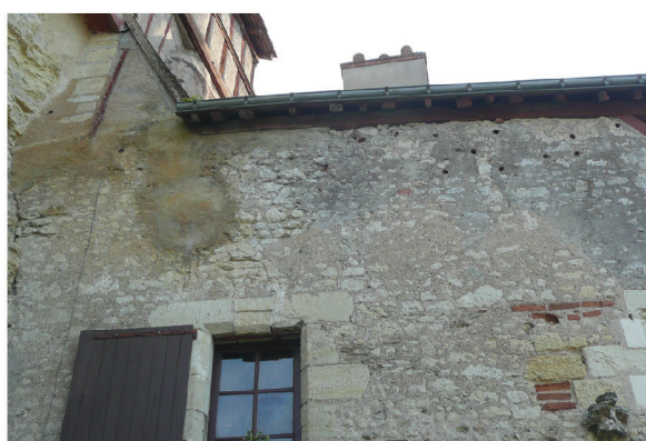
f : Amboise (37), n° 1 rue des Chatelliers
