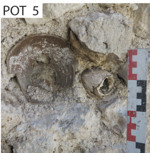
Fig. 18 : Orléans, maison n° 9 rue des Sept-Dormants : vue de pots à oiseaux n° 4 et 5 joutés d'une corne de bovidé (cliché : Clément ALIX, Pôle d'Archéologie Ville d'Orléans).
