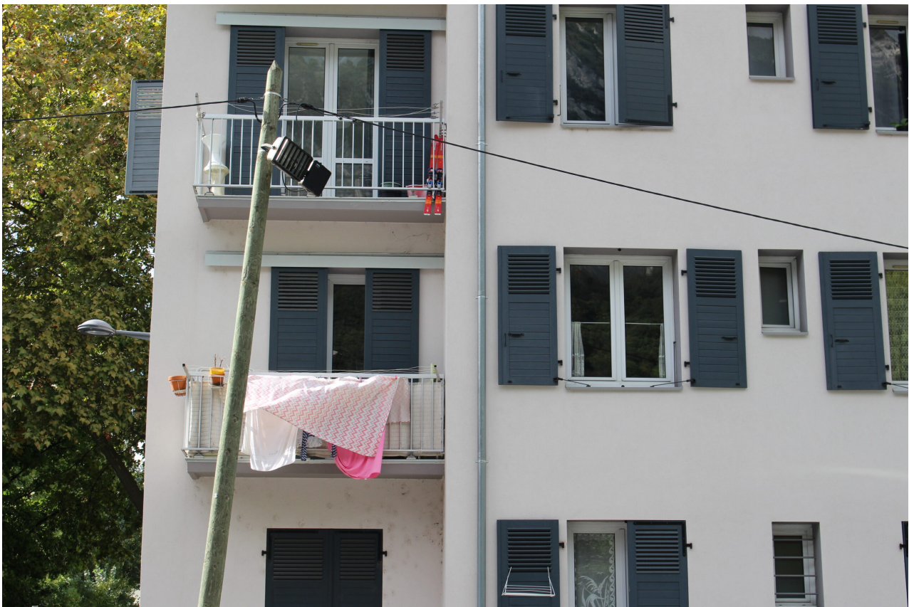
Ryma Hadbi, Bâtiment réhabilité de la cité Jean Macé, Grenoble (France), 2021, CC-BY-NC-SA, autorisation de diffusion
