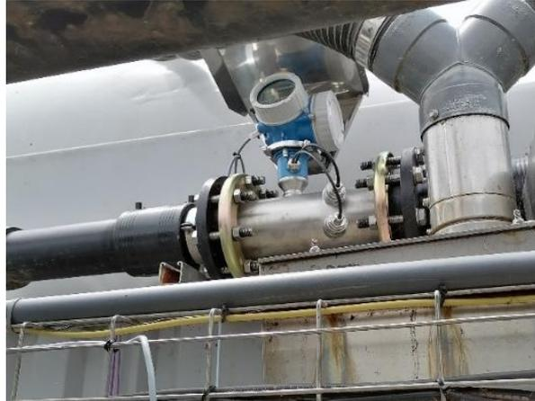
Figure 1: Débitmètre à ultrason sur la canalisation en sortie d'un digesteur de type garage (GAEC des Vallons)
