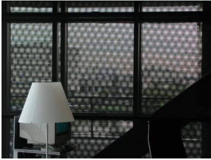
Fig. 9. Photos montrant les effets visuels de moirage générés par les grilles perforées
