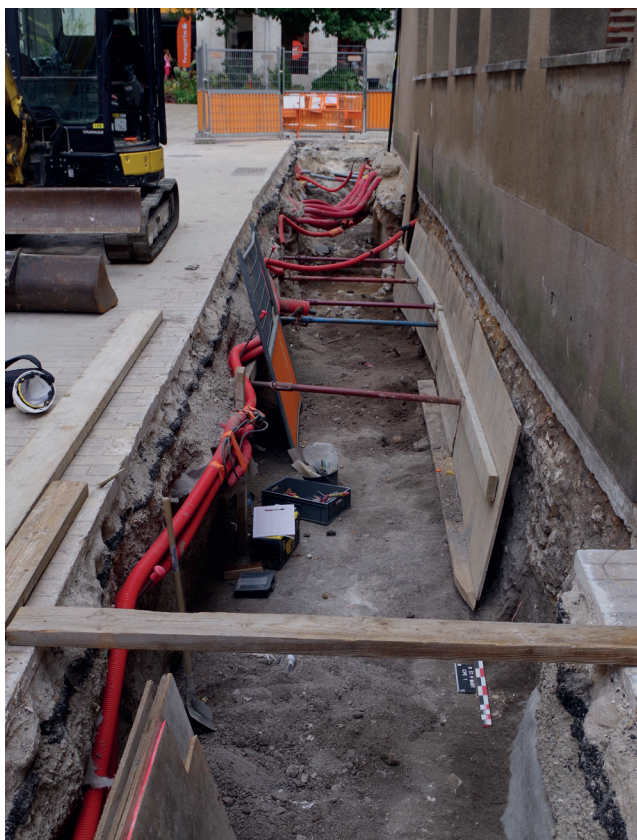
Fig. 8 : Partie nord de la tranchée (PAVO).
