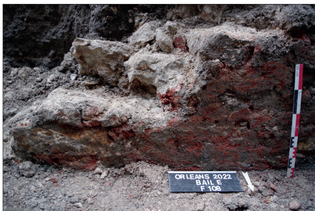
Fig. 32 : Mur sud de F 108, côté intérieur, avec l'enduit de tuileau rose encore présent (PAVO).
