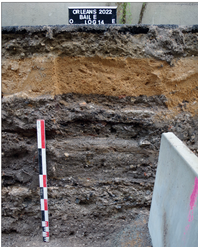
Fig. 33 : Log 14. Les matériaux de démolition du bâtiment de la fin du 18 e s. et épanchés sur le site se voient sous le sable ocre (PAVO).
