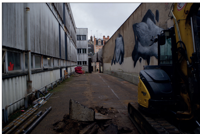
Fig. 10 : Vue de l'ouest de la cour arrière avant terrassement (PAVO).
