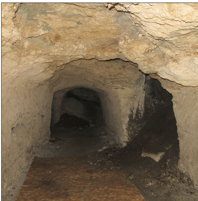
Fig. 46 : Deuxième niveau de cave (ES_7), vue interne vers le haut du conduit de puits d'extraction/aération dans la paroi orientale de la galerie nord (cliché Cl. Alix, Pôle d'Archéologie, ville d'Orléans).
