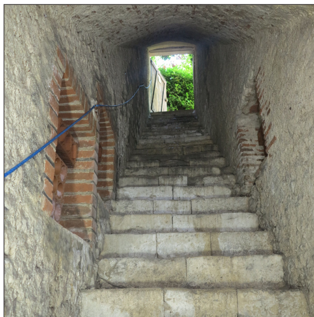
Fig. 28 : Escalier (ES_1), vue vers l'ouest de la cage maçonnée et des niches murales (cliché Cl. Alix, Pôle d'Archéologie, ville d'Orléans).
