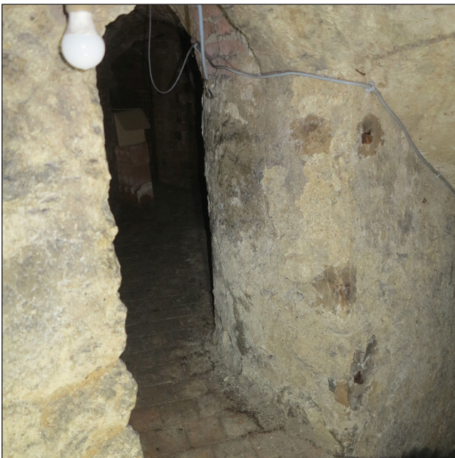
Fig. 35 : Premier niveau de cave (ES_4), vue de la porte d'entrée du couloir d'accès, aménagée dans la paroi nord de la cage d'escalier ES_1 (cliché Cl. Alix, Pôle d'Archéologie, ville d'Orléans).
