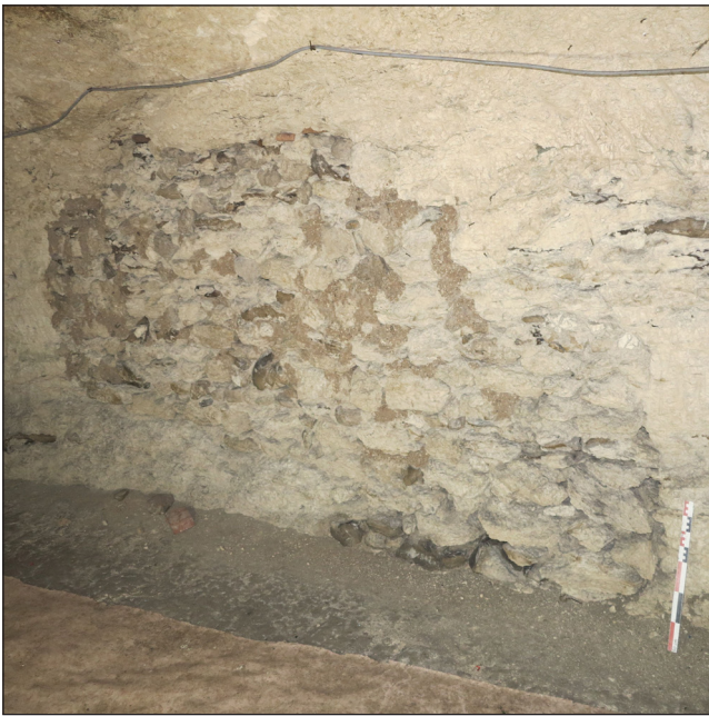
Fig. 41 : Deuxième niveau de cave (ES_6), vue du comblement maçonné (moellons) sur la paroi nord de la galerie sud (cliché Cl. Alix, Pôle d'Archéologie, ville d'Orléans).
