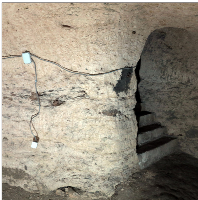
Fig. 29 : Escalier (ES_1), vue vers le nord-ouest du passage d'entrée vers l'escalier depuis la cave-carrière (cliché Cl. Alix, Pôle d'Archéologie, ville d'Orléans).
