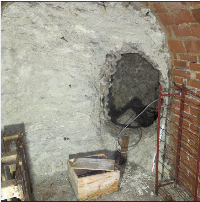
Fig. 33 : Premier niveau de cave (ES_2), vue de l'extrémité nord-est avec conduit de puits à eau (cliché Cl. Alix, Pôle d'Archéologie, ville d'Orléans).
