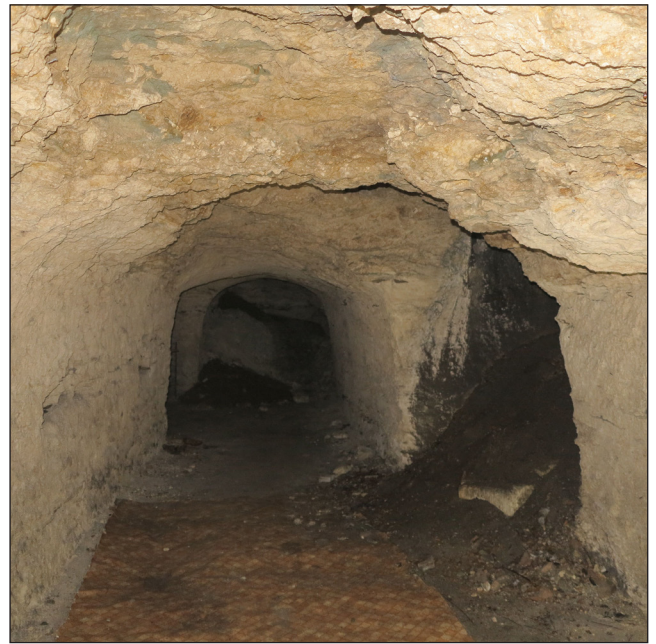
Fig. 42 : Deuxième niveau de cave (ES_7), vue d'ensemble vers le nord de la galerie nord, avec rétrécissement de sa largeur et ouverture du conduit d'extraction/aération à droite (cliché Cl. Alix, Pôle d'Archéologie, ville d'Orléans).
