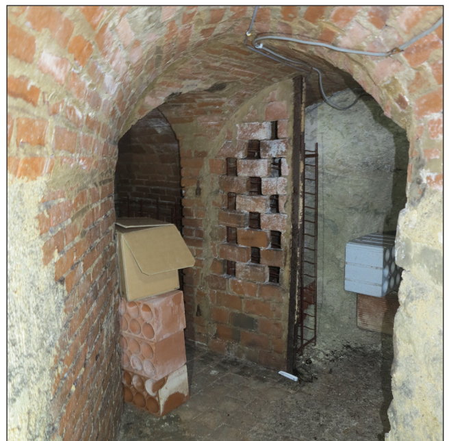
Fig. 36 : Premier niveau de cave (ES_2), vue vers le nord-est des voûtes de renfort et des parements en brique, depuis le couloir d'accès ES_4 (cliché Cl. Alix, Pôle d'Archéologie, ville d'Orléans).
