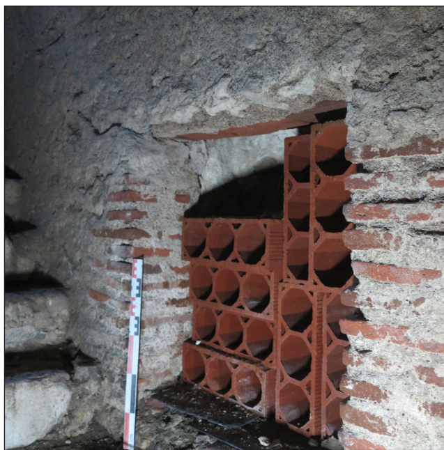
Fig. 30 : Escalier (ES_1), vue vers le nord-ouest de la niche dans la paroi nord de l'escalier (cliché Cl. Alix, Pôle d'Archéologie, ville d'Orléans).
