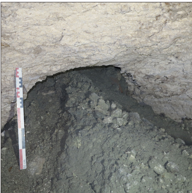
Fig. 43 : Deuxième niveau de cave (ES_7), vue de l'extrémité septentrionale de la galerie nord, avec rétrécissement conduit d'extraction/aération comblé (cliché Cl. Alix, Pôle d'Archéologie, ville d'Orléans).
