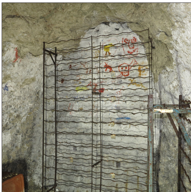
Fig. 31 : Premier niveau de cave (ES_2), vue vers le sud de l'extrémité méridionale (cliché Cl. Alix, Pôle d'Archéologie, ville d'Orléans).
