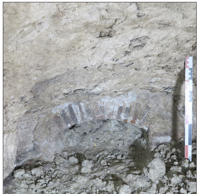
Fig. 44 : Deuxième niveau de cave (ES_8), vue de l'extrémité de la galerie nord-ouest, avec paroi maçonnée et porte d'accès à un puits à eau probablement aménagé dans un ancien puits d'extraction (cliché Cl. Alix, Pôle d'Archéologie, ville d'Orléans).
