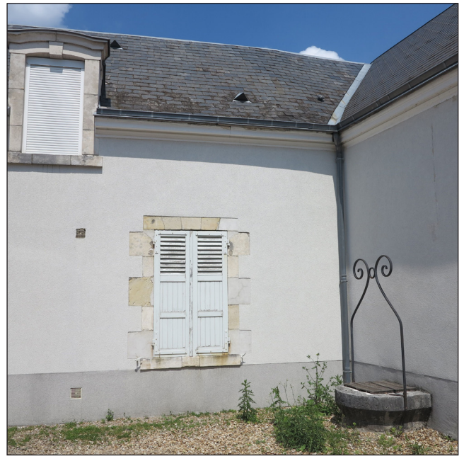
Fig. 34 : Cour de la maison, vue vers le nord-est de la margelle du puits à eau également accessible depuis le premier niveau de cave ES_2 (cliché Cl. Alix, Pôle d'Archéologie, ville d'Orléans).
