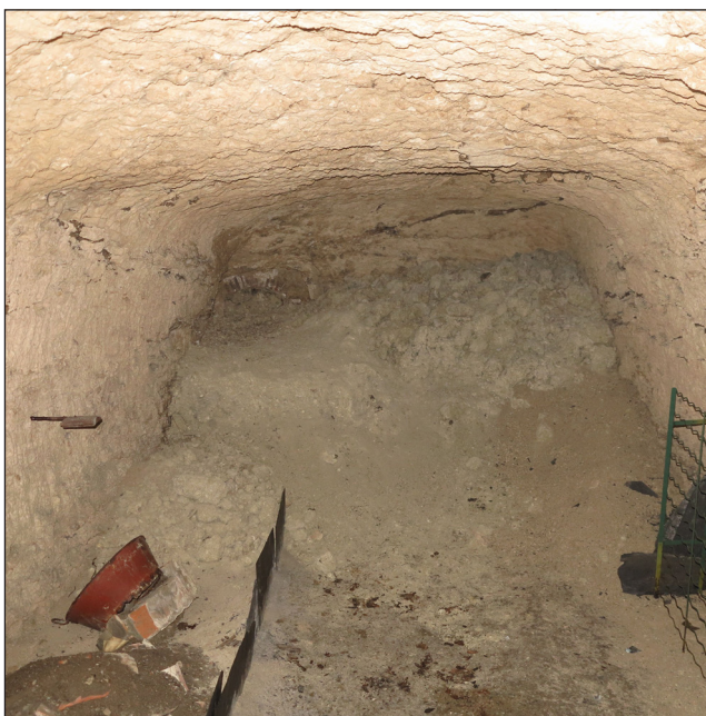
Fig. 38 : Deuxième niveau de cave (ES_8), vue vers l'est de l'extrémité de la galerie nord-ouest et de son couvremment (cliché Cl. Alix, Pôle d'Archéologie, ville d'Orléans).
