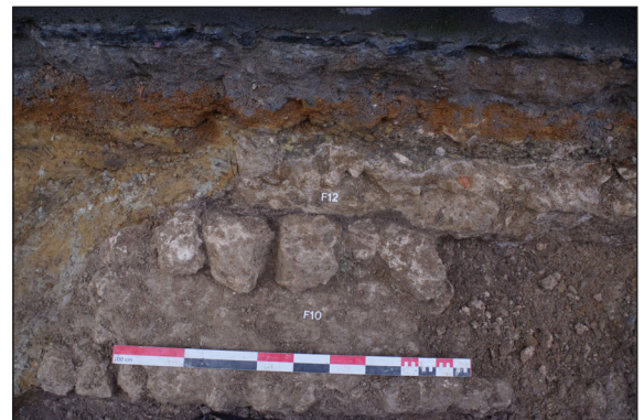
Fig. 42 : Vue de la fondation maçonnée F 10 et de la maçonnerie indéterminée F 12.
