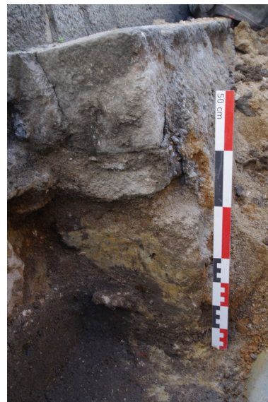
Fig. 22 : Vue de la coupe 1 (le log 25 a été pratiqué au droit du trottoir actuel, à gauche de la photographie).
