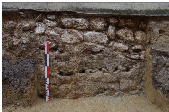
Fig. 32 : Vue de F 1. On peut observer le plaquage du mortier gris contre les assises en partie basse.
