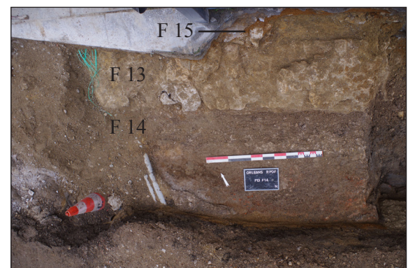
Fig. 43 : Vue de la fondation de maçonnerie F 13, de sa tranchée de fondation F 14 et de la petite maçonnerie indéterminée F 15.
