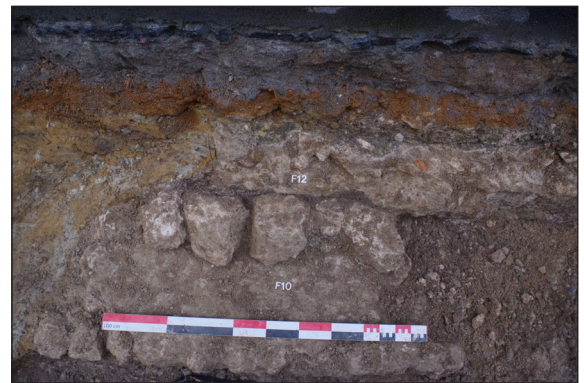
Fig. 42 : Vue de la fondation maçonnée F 10 et de la maçonnerie indéterminée F 12.
