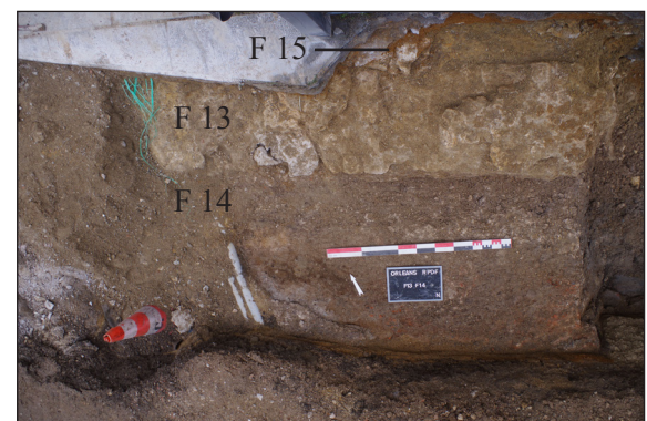
Fig. 43 : Vue de la fondation de maçonnerie F 13, de sa tranchée de fondation F 14 et de la petite maçonnerie indéterminée F 15.
