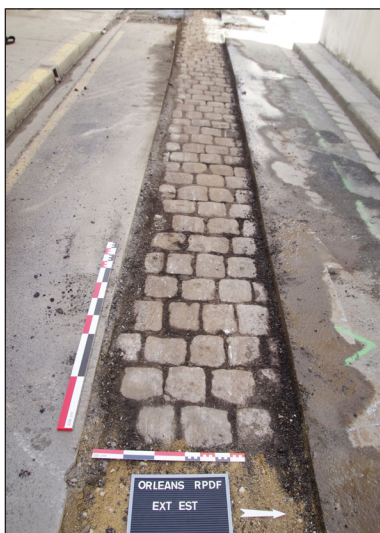
Fig. 48 : Vue du pavage F 6 après décroûtage de l'enrobé.
