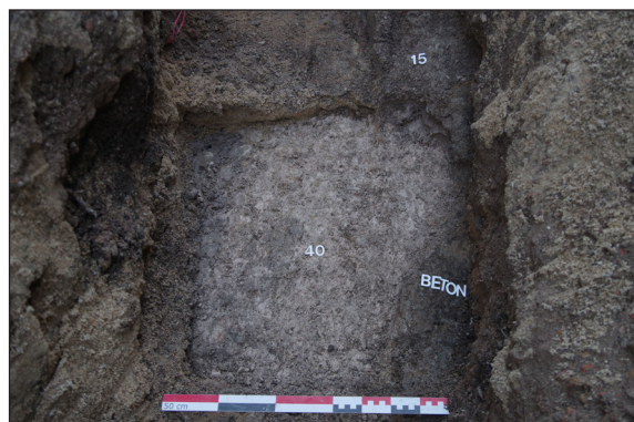
Fig. 27 : Vue de l'US 40 située sous l'US 15 au fond de la tranchée 5. L'élément en béton date du 20 e s.
