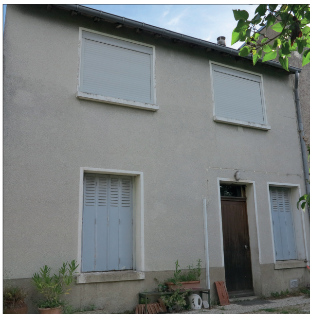
Fig. 29 : Vue de la façade sur cour (mur gouttereau sud) du corps d'habitation, vers le nord-est (photographie n° 149 ; cliché : Cl. Alix).
