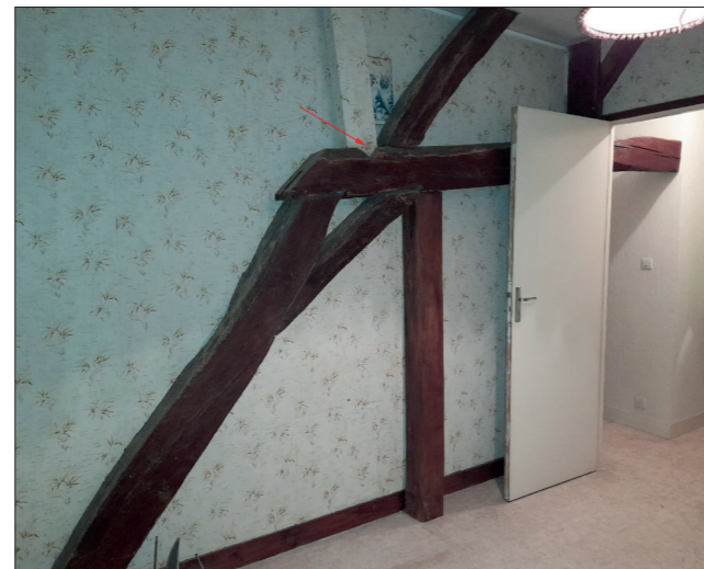
Fig. 30 : Vue de la ferme de la charpente de comble du corps d'habitation, avec remaniements liés à la surélévation à gauche (potelet à l'emplacement de l'ancienne panne), vers nord-ouest (photographie n° 108 ; cliché : Cl. Alix).
