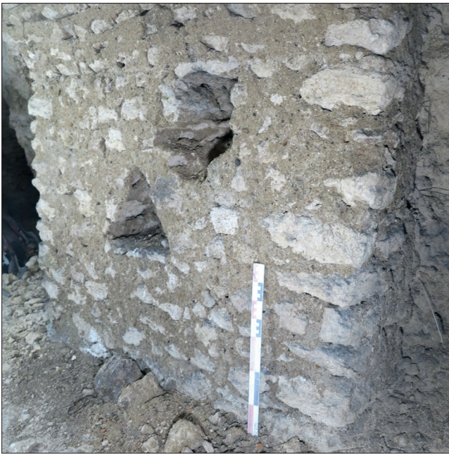
Fig. 52 : Vue du parement occidental du passage voûté, plaqué contre la paroi de la galerie ES_013, intégrant un niche NIC 609 et un vide-poche NIC 610, vers le sud-ouest (photographie n° 069 ; cliché : Cl. Alix).
