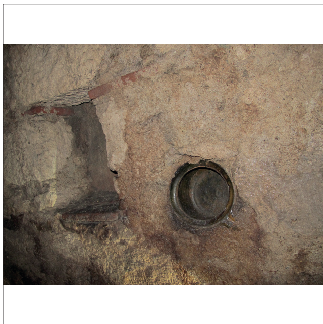
Fig. 65 : Orléans, 83 rue Malakoff (SICAVOR n° 13), céramique servant de vide-poche et petite niche dans la paroi d'une cellule de l'escalier de la cave-carrière, 18 e s., vers le sud (photographie n° 150 ; cliché : Cl. Alix).
