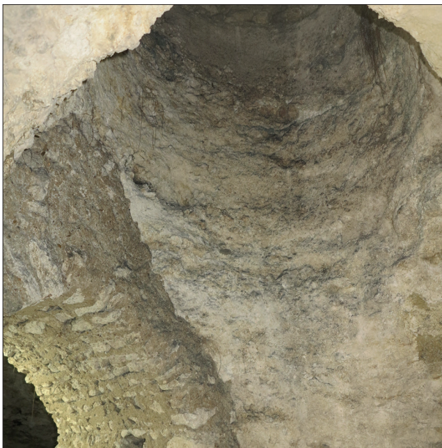
Fig. 50 : Vue de la voûte du passage maçonné (UC 6006) de la galerie ES_13, jouxtant le conduit du puits PUI 613, contre-plongée vers l'ouest (photographie n° 068 ; cliché : Cl. Alix).
