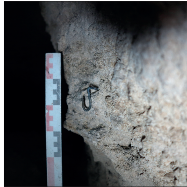
Fig. 61 : Détail d'un crochet fiché dans la paroi sud de la galerie ES_16, vers l'est (photographie n° 061 ; cliché : Cl. Alix).
