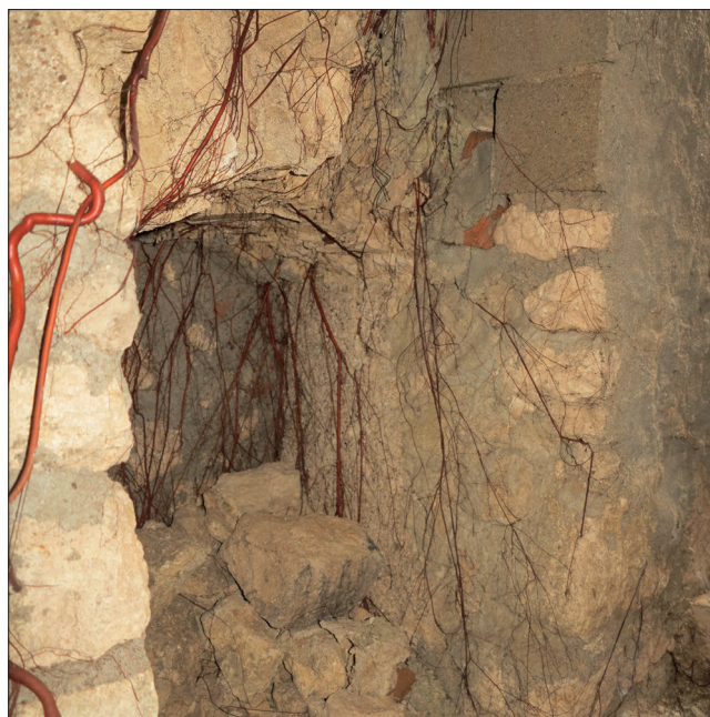
Fig. 69 : Vue de la reprise au ciment (UC 6004) de la paroi nord de la cage d'escalier ES_600 près de la cellule CEL 603, vers le sud-est (photographie n° 125 ; cliché : Cl. Alix).
