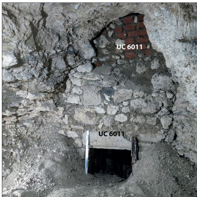
Fig. 56 : Vue de la paroi de fermeture (UC 6009) du puits à eau PUI 607, de son ouverture et de sa réparation (UC 6011) en partie haute, vers le sud-ouest (photographie n° 077 ; cliché : Cl. Alix).
