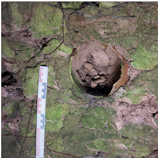
Fig. 48 : Vue de la céramique engagée dans la paroi nord de la cage d'escalier, servant de vide-poche (NIC 604), vers le nord-ouest (photographie n° 101 ; cliché : Cl. Alix).
