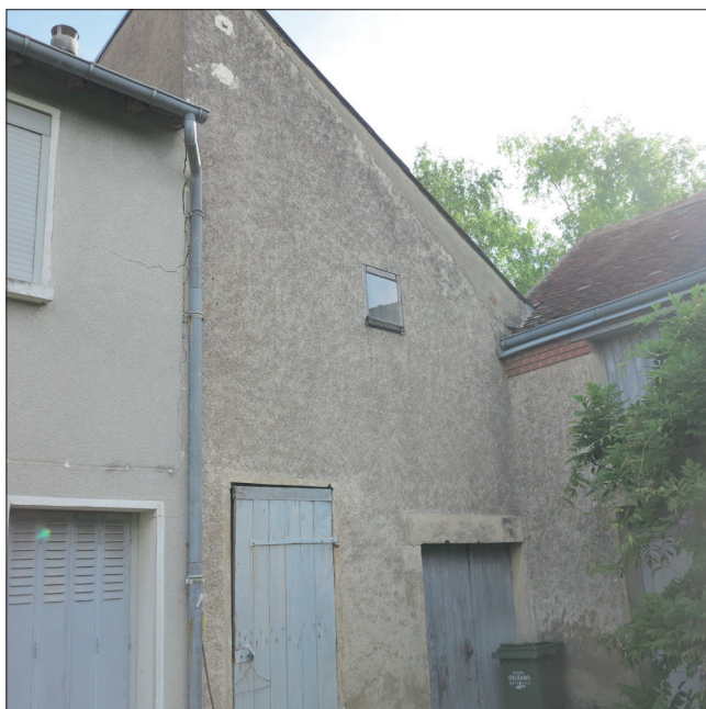
Fig. 27 : Vue des façades sur cour des bâtiments, de gauche à droite habitation, grange et resserre, vers le nord-est (photographie n° 147 ; cliché : Cl. Alix).
