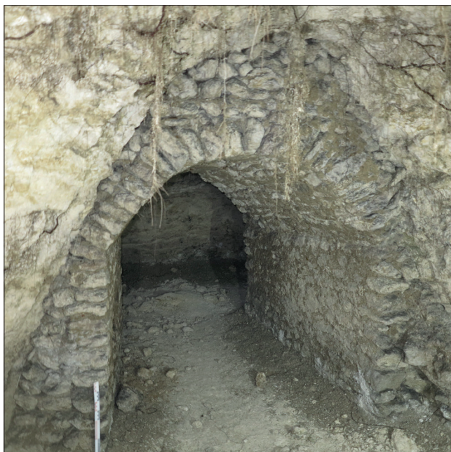
Fig. 49 : Vue d'ensemble du passage voûté (UC 6006) à l'extrémité de la galerie ES_013, vers le sud (photographie n° 070 ; cliché : Cl. Alix).
