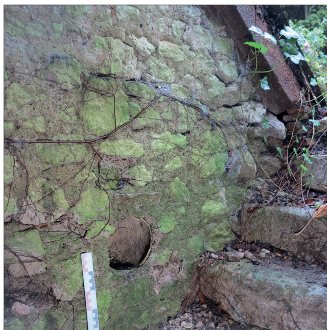
Fig. 47 : Vue de la céramique engagée dans la paroi nord de la cage d'escalier, servant de vide-poche (NIC 604), vers le nord-est (photographie n° 100 ; cliché : Cl. Alix).
