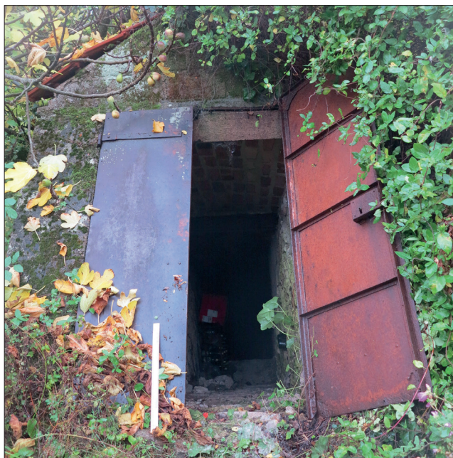
Fig. 67 : Vue de la porte à double vantaux métalliques de l'escalier ES_600, vers l'ouest (photographie n° 105 ; cliché : Cl. Alix).
