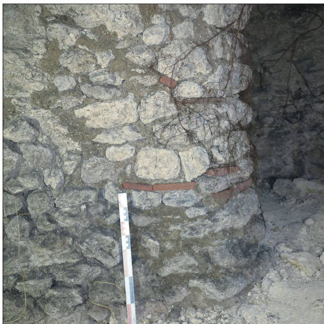
Fig. 41 : Détail de la maçonnerie (UC 6014) de la tête du mur d'échiffre nord de l'escalier (ESC 600) et de son retour sous forme de parement maçonné dans la galerie ES_04, vers l'est (photographie n° 088 ; cliché : Cl. Alix).
