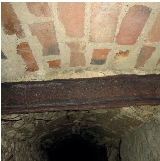
Fig. 68 : Vue de la reprise du sommet de la voûte (UC 6005) de l'escalier ES_600, vers le sud-ouest (photographie n° 103 ; cliché : Cl. Alix).
