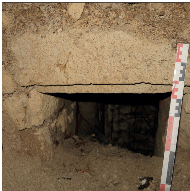
Fig. 57 : Vue de l'ouverture de la paroi de fermeture (UC 6009) du puits à eau PUI 607, vers le sud-ouest (photographie n° 130 ; cliché : Cl. Alix).
