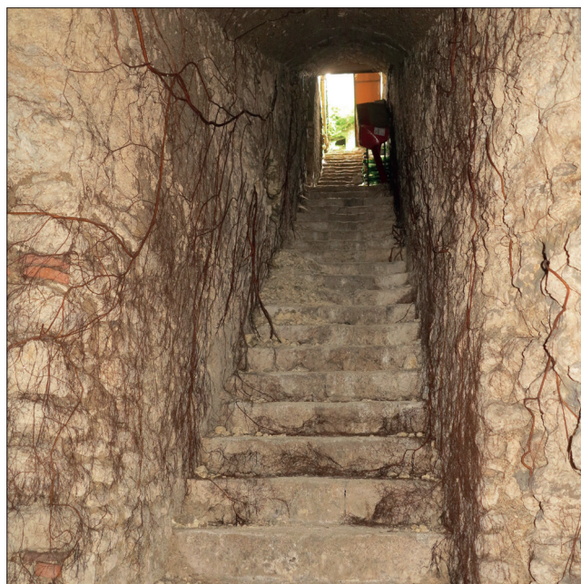
Fig. 39 : Vue d'ensemble de l'escalier ES_01 (ESC 600), vers le nord-est (photographie n° 121 ; cliché : Cl. Alix).
