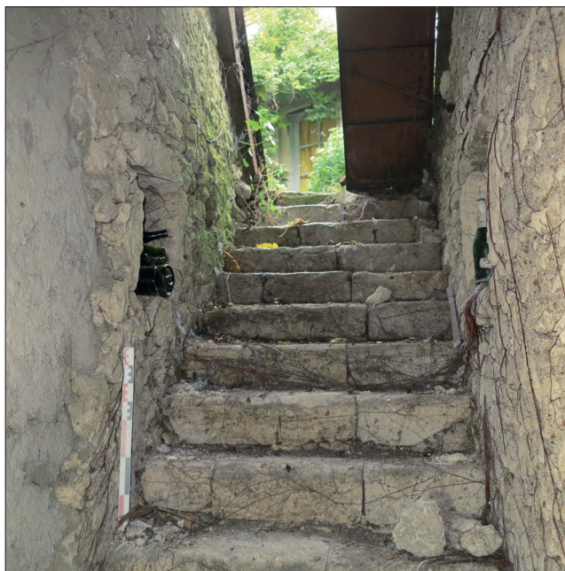
Fig. 43 : Vue du sommet de l'escalier avec niches murales NIC 601 et NIC 614 se faisant face, vers le nord-est (photographie n° 096 ; cliché : Cl. Alix).
