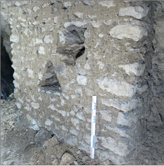
Fig. 52 : Vue du parement occidental du passage voûté, plaqué contre la paroi de la galerie ES_013, intégrant un niche NIC 609 et un vide-poche NIC 610, vers le sud-ouest (photographie n° 069 ; cliché : Cl. Alix).
