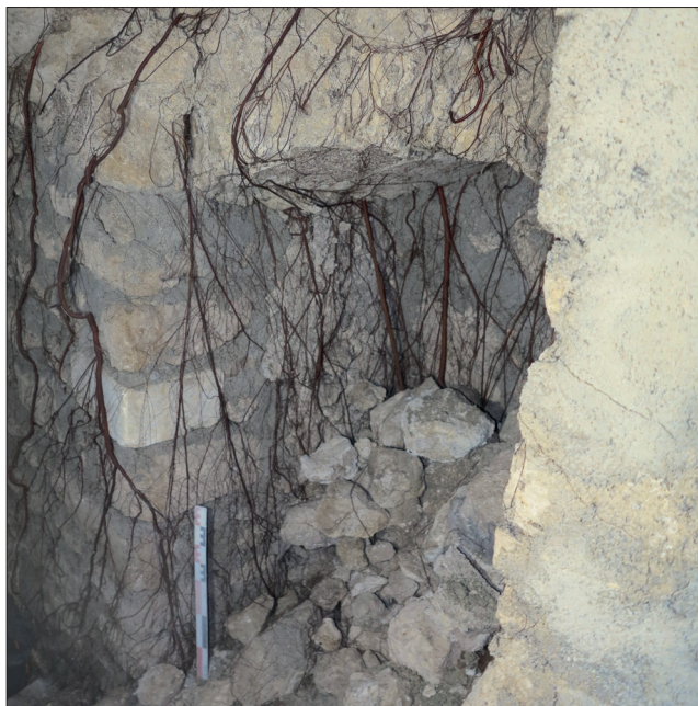
Fig. 42 : Vue de la cellule CEL 603 ouverte dans la paroi nord du repos de l'escalier ESC 600, vers le nord-ouest (photographie n° 095 ; cliché : Cl. Alix).
