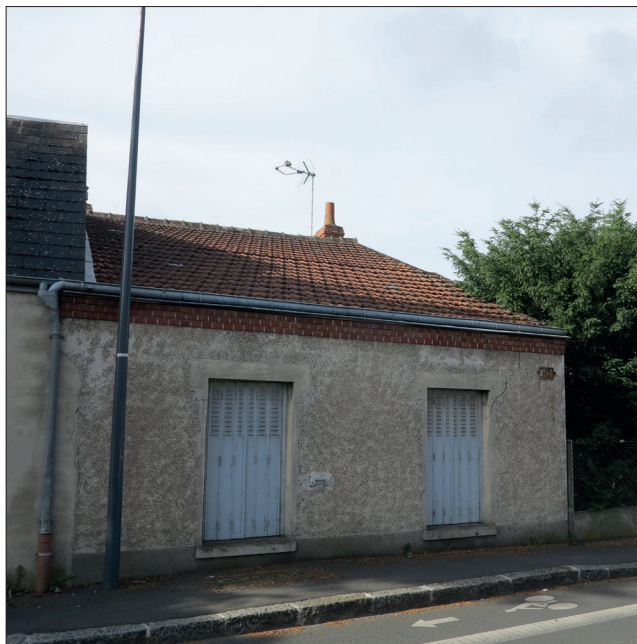
Fig. 28 : Vue de la façade sur rue (mur gouttereau nord) du corps d'habitation, vers le sud-ouest (photographie n° 148 ; cliché : Cl. Alix).
