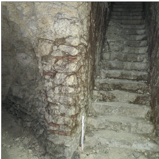
Fig. 40 : Vue d'ensemble de la tête du mur d'échiffre nord de l'escalier (ESC 600) et de son retour sous forme de parement maçonné (UC 6014) dans la galerie ES_04, vers le nord-est (photographie n° 090 ; cliché : Cl. Alix).
