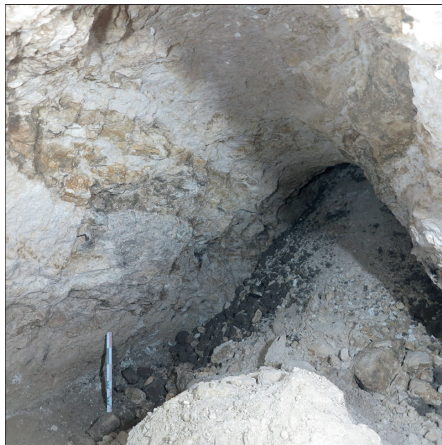
Fig. 38 : Vue de la cellule ES_18 et du puits d'extraction/aération PUI 611, comblé avec un remblai déversé depuis la surface, vers le nord-est (photographie n° 063 ; cliché : Cl. Alix).
