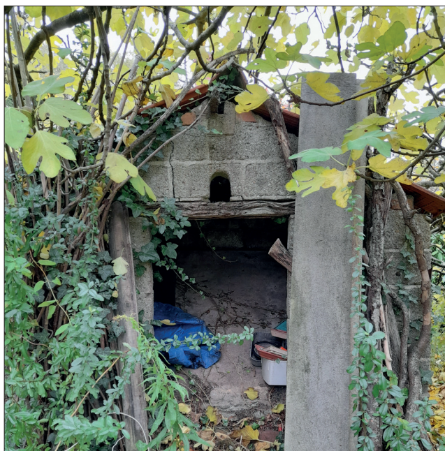
Fig. 66 : Vue de l'édicule protégeant le sommet de la voûte de l'escalier ES_600, vers l'est (photographie n° 113 ; cliché : B. Lefèvre).
