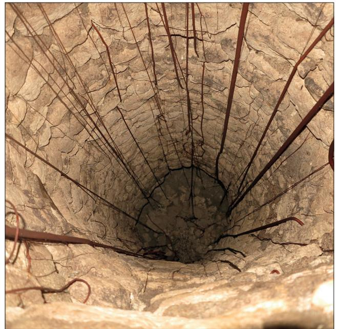
**Fig. 55 :** Vue vers le bas du conduit maçonné du puits à eau PUI 607 et de son comblement actuel (photographie n° 079 ; cliché : Cl. Alix).
