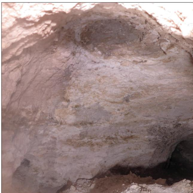
**Fig. 32** : Vue d'une cloche de fontis en formation dans le ciel de la galerie ES\_16, entraînant un effondrement de calcaire au niveau du sol, vers le nord-est (photographie n° 059 ; cliché : Cl. Alix).
