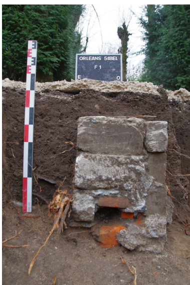
Fig. 25 : Vue frontale du regard de réseau F 1 recouvert par l'US 1001 (photo 016 ; cliché : L. Guyot).
