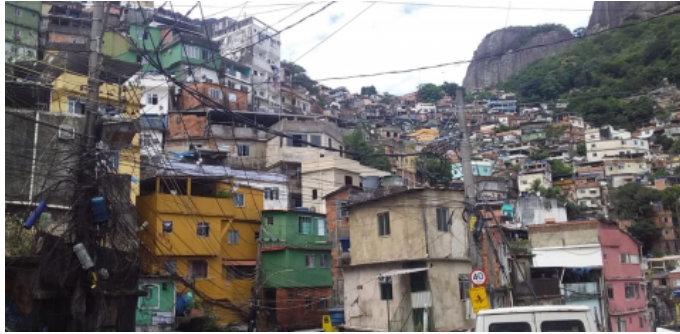
Figure 2. Façades colorées et fraîchement peintes sur Estrada da Gavea
