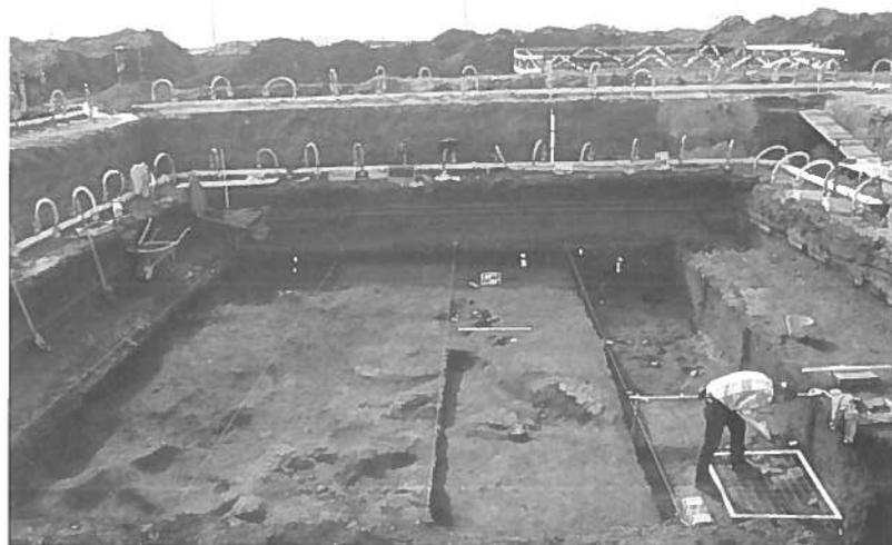
Fig. 18 - Saggio 1 con la sistemazione del wellpoint.
