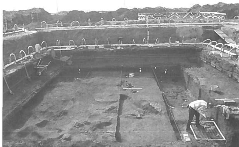
Fig. 18 - Saggio 1 con la sistemazione del wellpoint.
