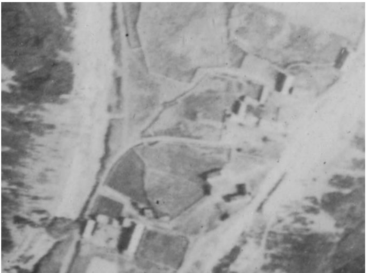
Fig. 23 – Extraits d’une photographie aérienne de l’île de Béniguet prise en 1919. En haut, vue large sur la zone centrale ; en bas, vue resserrée sur les habitations et les bâtiments (© SHOM, Ifremer, Photothèque nationale).
