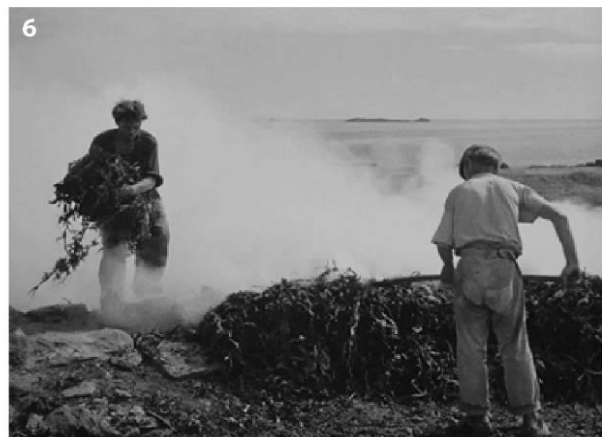
Fig. 26 – Chaîne opératoire de fabrication des pains de soude (1/3). 1, remontée du goémon sur la dune ; 2, déchargement du goémon sur la dune ; 3, étalage du goémon mouillé sur la dune ; 4, étalage et retournement du goémon ; 5, petits tas de goémons semi-secs sur la dune ; 6, petits tas de goémons semi-secs sur le cordon de galets du haut d'estran (d'après le film Goémons de Y. Bellon, 1948).
