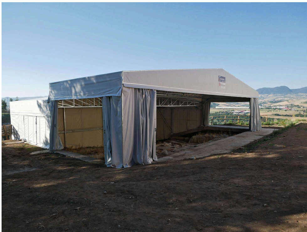
Fig. 1. Nouvelle structure de protection du site du Cimitero di Atella, mission, 2022.
